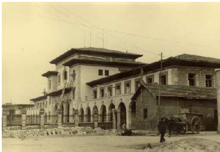
Obras de reconstrucción de la Estación del Norte de Oviedo, ca. 1946.
