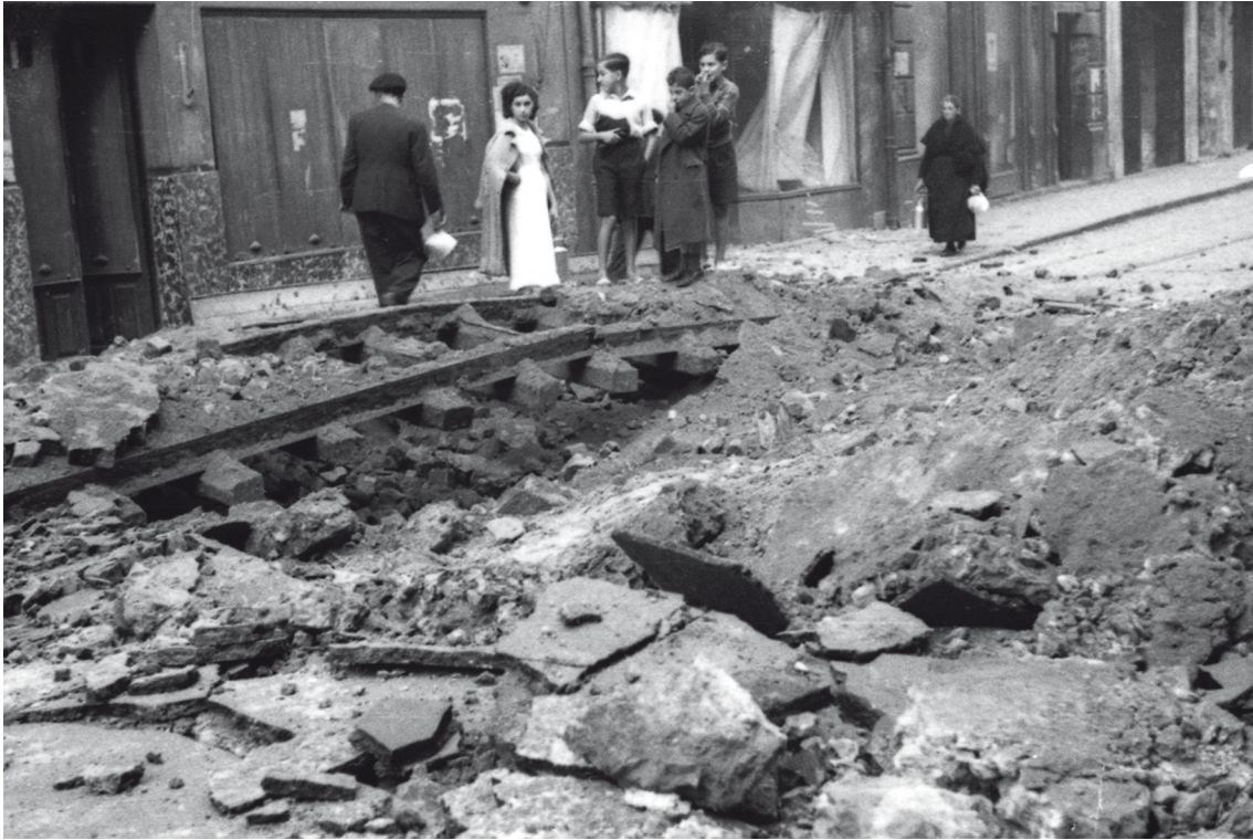
Vías del tranvía dañadas tras un bombardeo, posiblemente en la calle de los Moros
