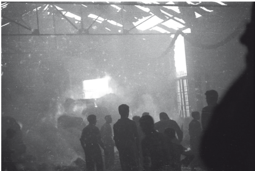
Instalaciones industriales dañadas por los bombardeos
