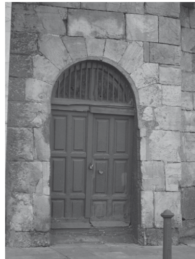
Estado actual de la entrada al túnel de Cimavilla desde la calle Claudio Alvargonzález
