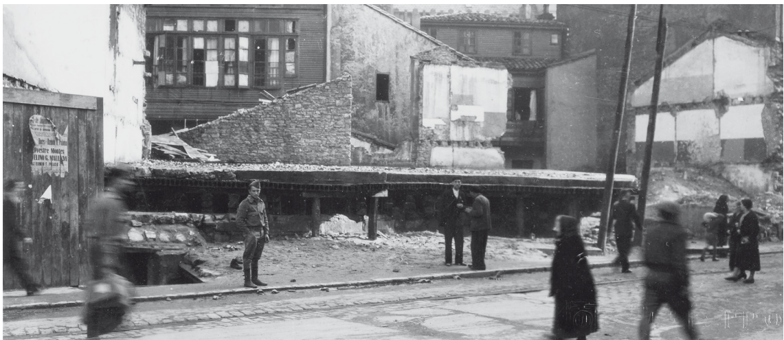
Refugio de nueva construcción en la calle Menéndez Valdés (ubicación actual, calle Menéndez Valdés, 1-3)
