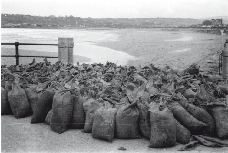
Sacos terreros preparados en la Escalerona tras ser rellenos con arena de la playa
