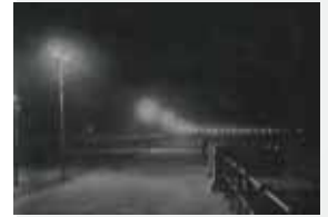
Vista nocturna del paseo del Muro. Año 1929. (AMG. Colección del Padre Patac).
