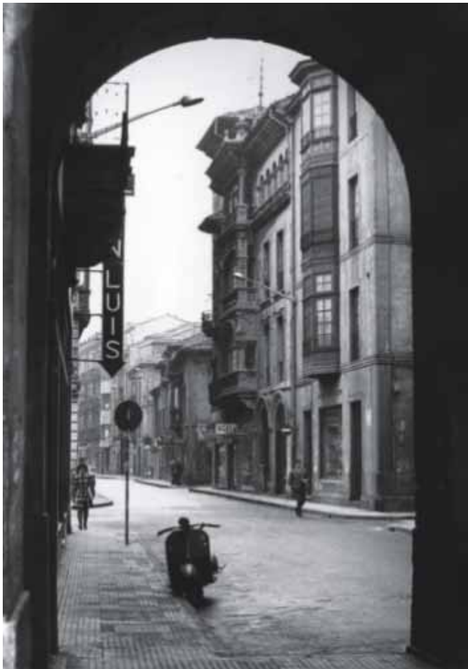
En la década de los setenta eran muy habituales las luminarias "de pared", situadas por lo general en fachadas por encima de los nueve metros de altura. (AMG. Colección del Padre Patac).
