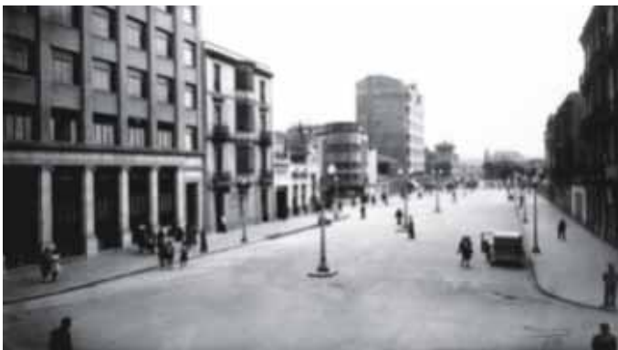
La calle Álvarez Garaya con una hilera de farolas en el centro de la calzada. Primeros años de la década de los cuarenta. (AMG).
