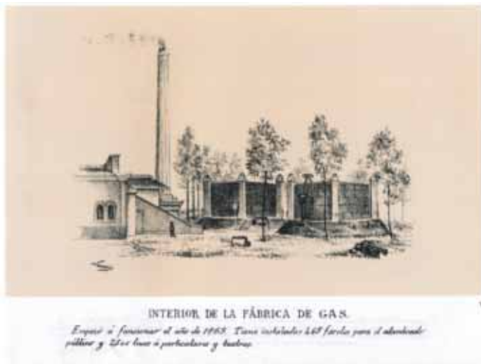
La primera imagen de la Fábrica del Gas, en el Ensanche de Los Arenales. (Reproducción de la Guía Ilustrada de Gijón , de Nemesio Martínez).
