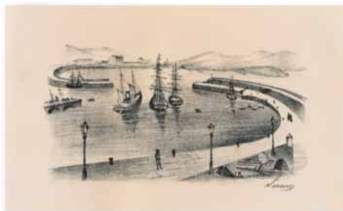
ANTE-PUERTO. MUELLE DE LIQUÉRICA. Se construyó desde el año de 1859 al 1864 y lleva el nombre del capitán que dirigió los obras.
