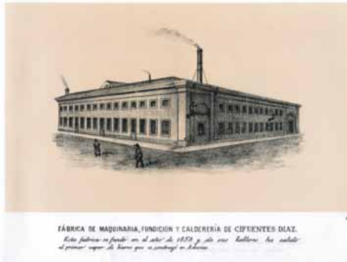
Fábrica de Cifuentes Díaz con farolas adosadas a su fachada principal. Se dedicaba, entre otras cosas, a la fundición. (Reproducción de la Guía Ilustrada de Gijón , de Nemesio Martínez).
