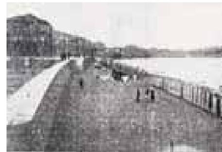
postería trabada con mortero hidráulico y asentado sobre una cimentación de hormigón en masa; si su parte vista adopta la forma de talud levemente inclinado, la interna –posteriormente enterrada bajo el relleno de la avenida– se escalona. El remate, una coronación formada por un botaolas continuo de sillería caliza.
