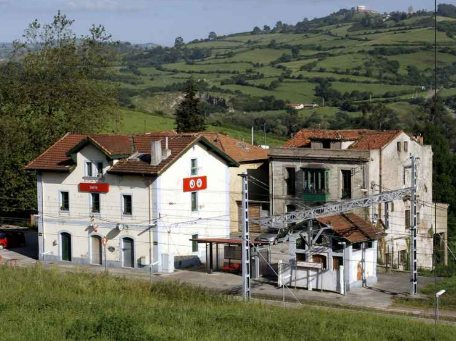
Antigua estación de Renfe
