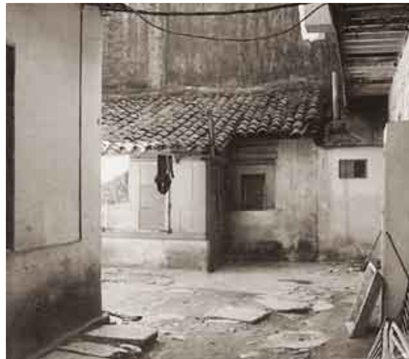
Ciudadela de la calle Garcilaso; en esta zona del ensanche la construcción de las ciudadelas de pequeño tamaño fue muy abundante
