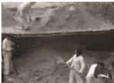
Albañiles trabajando en la construcción de un muro, h. 1930 (Constantino Suárez, Archivo Municipal de Gijón)
