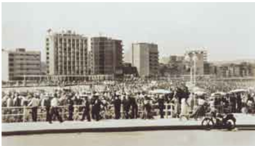
Edificios en construcción en el paseo del Muro, a principios de 1960 (archivo del Museo del Pueblo de Asturias)
