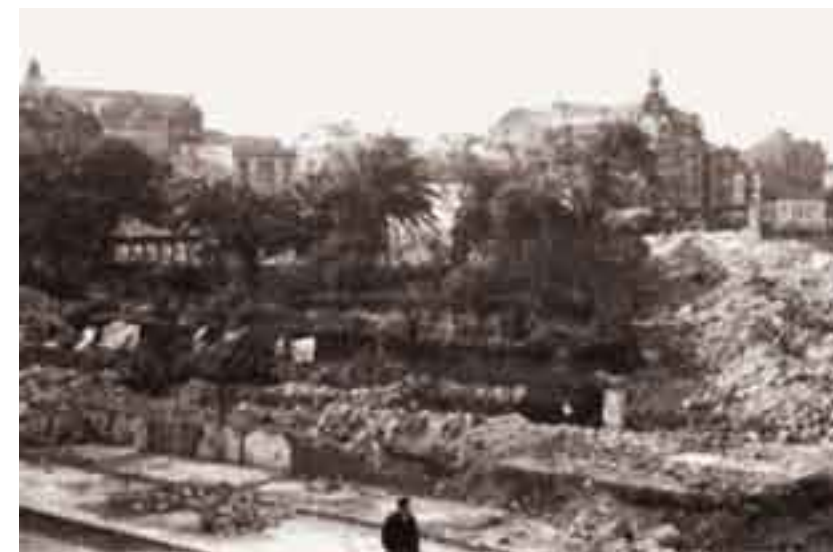
Ruinas del Hospital de Caridad mandado derribar por la gestora presidida por Avelino Mallada durante la guerra civil (Constantino Suárez, Archivo Municipal de Gijón)
