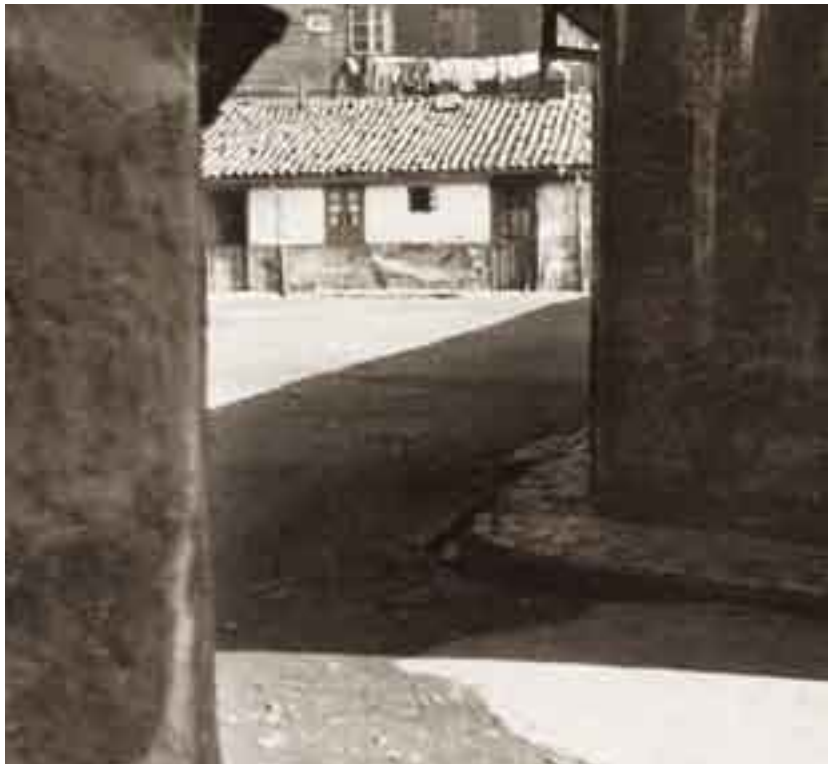
El llamado por los propios vecinos patio grande de la ciudadela de Capua
