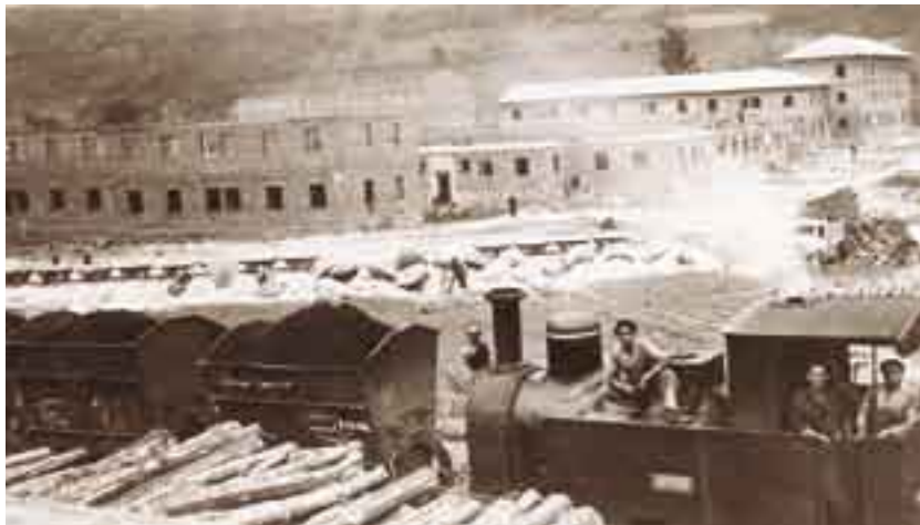
Construcción del barrio de San Pedro en Mieres, h. 1950 (archivo del Museo del Ferrocarril de Asturias)
