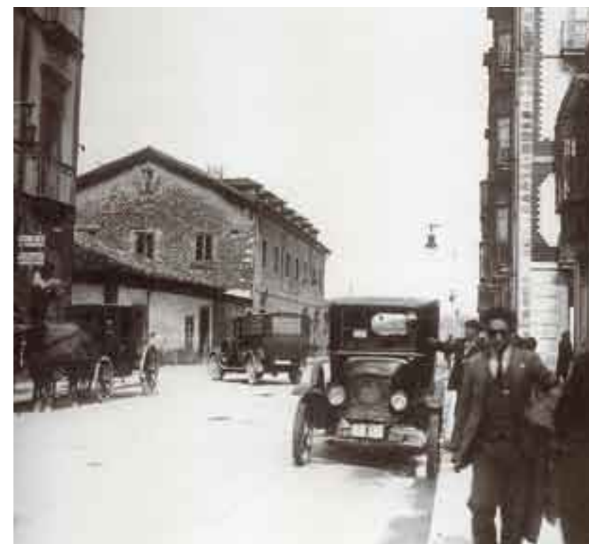
Típicas viviendas obreras de planta baja, piso y buhardillas en la calle Jovellanos a principios del siglo xx (archivo del Museo del Ferrocarril de Asturias)
