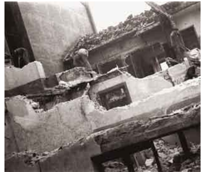
Obreros trabajando en los derribos establecidos por el Plan de Reformas de Avelino Mallada, 1937 (Constantino Suárez, Archivo Municipal de Gijón)
