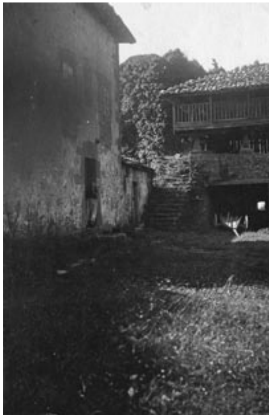
Figura 41. Panera de Villademoros (Luarca).
