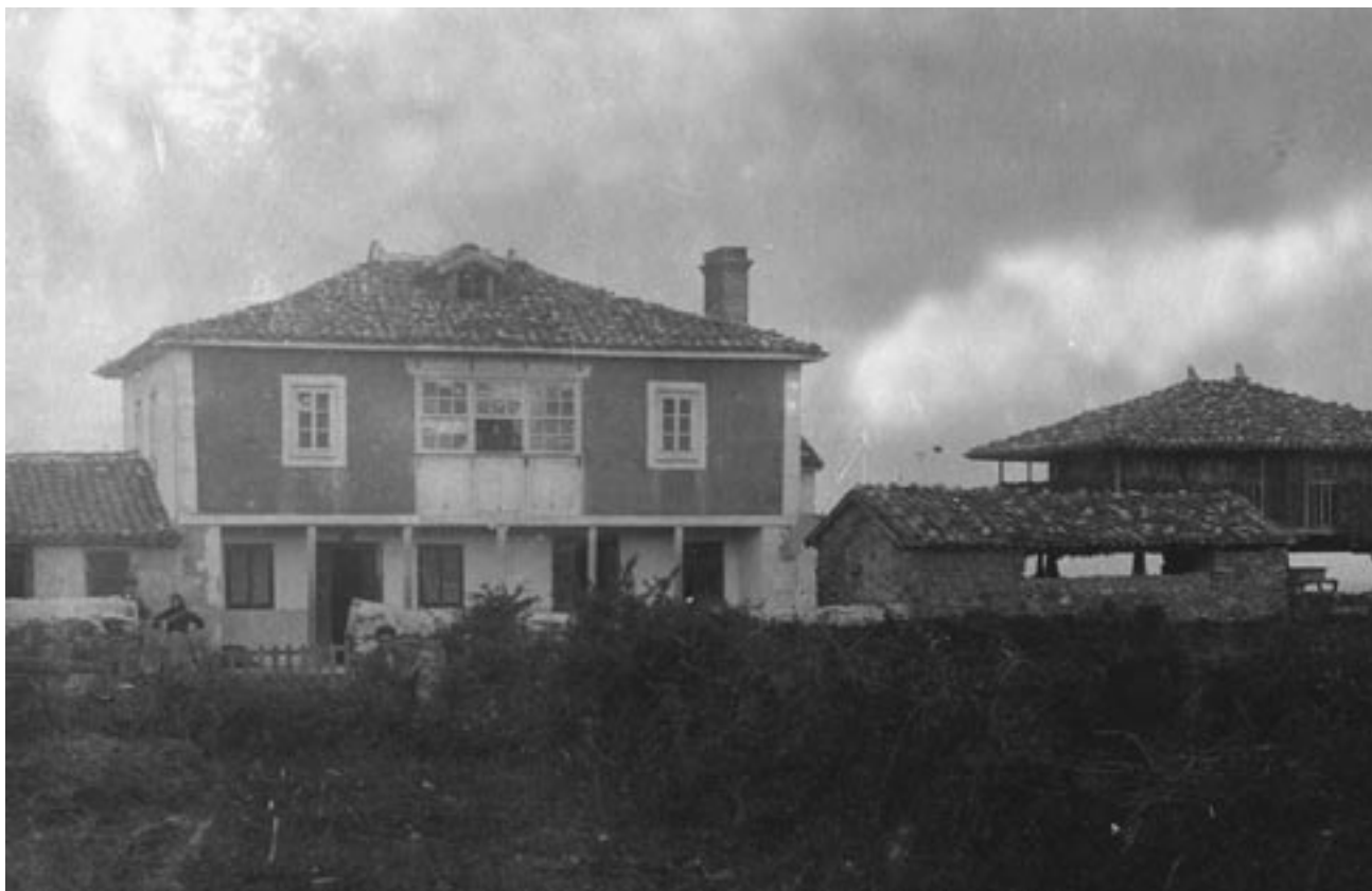
Figura 27. Construcciones de Novellana (Cudillero).
