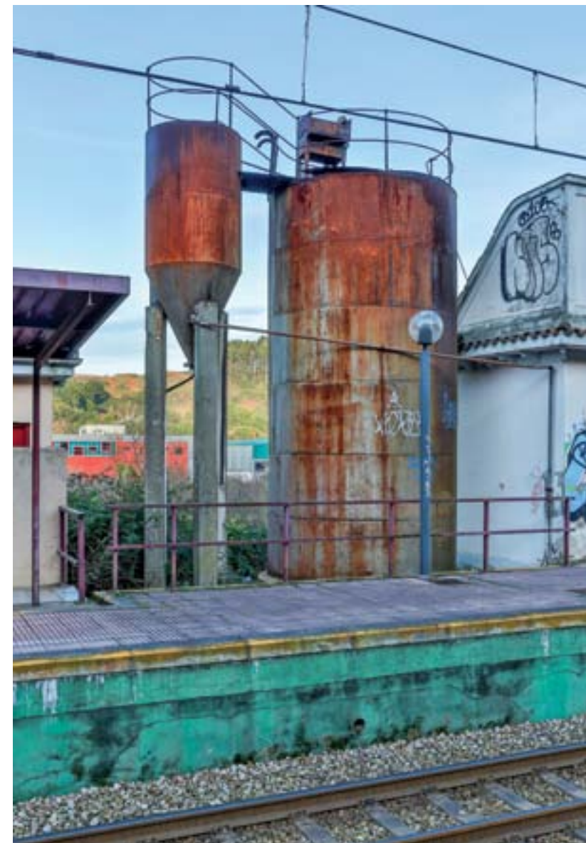
Aguada de la estación de tren de Sotiello L'Abadía Cenero. Camín de la Estación de Sotiello, 210
