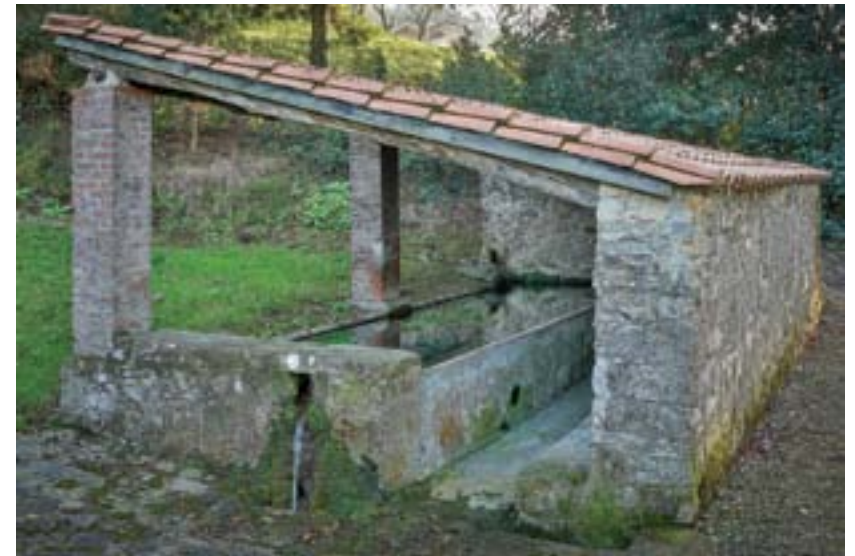
L'Arrionda (fuente, lavadero) Leorio / Llorio. Camín de L'Arrionda
