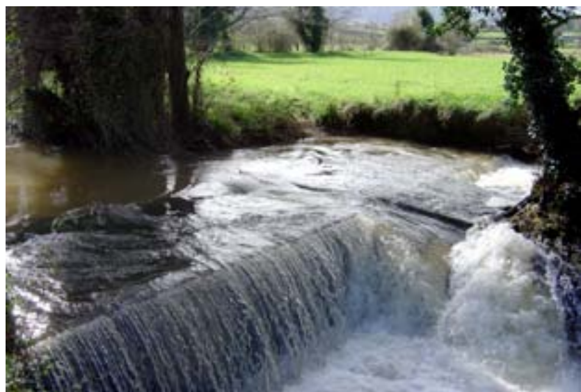
~ ESTA PÁGINA Presa del canal de Cagüezo Samartín de Güercos, Río Llantones Presa del canal de Los Molinos Vega, Río Piles
