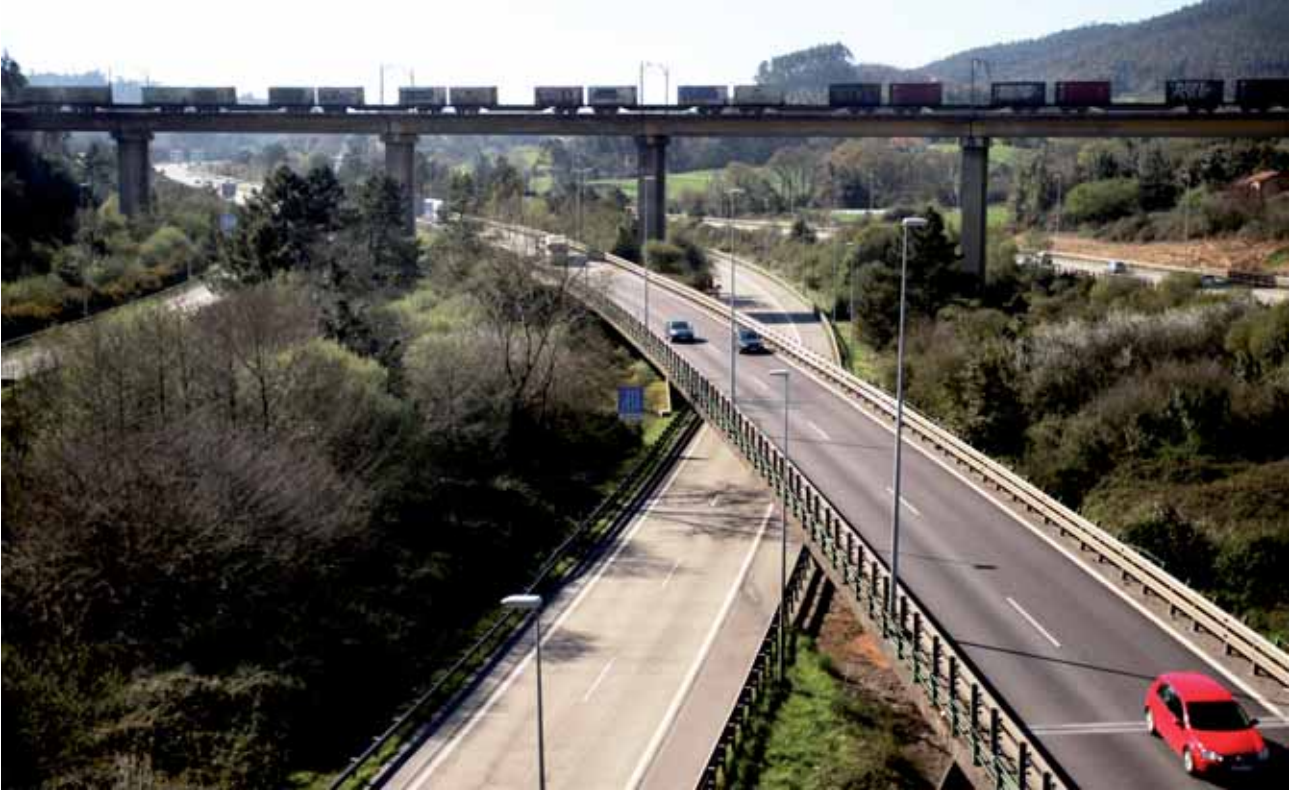
Autopista "Y griega"
