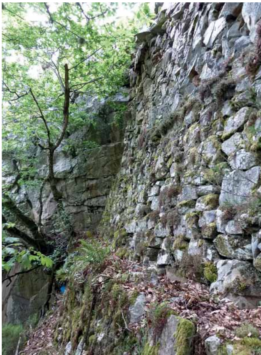
Paredón de cimentación del camino del Penedón.
