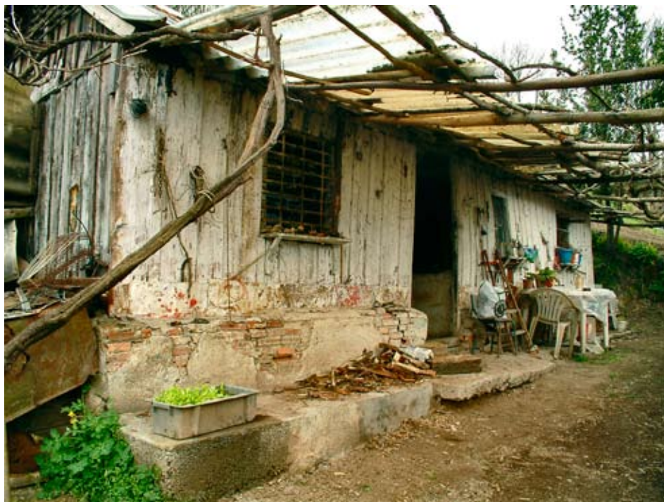
Barraca de madera que aún se conserva en Repipe (Turón), el ejemplo más modesto de vivienda obrera promovido por las empresas mineras. Fotografía de Roberto Álvarez Espinedo.
