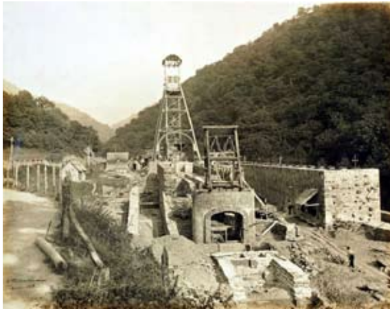
Foto 1 de Vallet de Montano. Profundización del pozo Santa Bárbara: vista general de la plaza.
