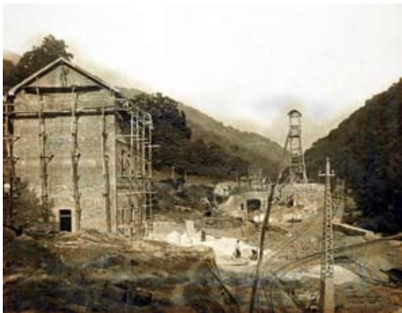
Foto 3 de Vallet de Montano. Instalaciones de superficie del pozo Santa Bárbara: en primer término, economato en construcción.
