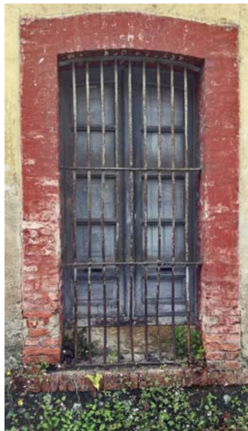
Detalle de la carpintería de la ventana del economato de La Rebaldana que aún conserva las ranuras para introducir las libretas. Fotografía de M. a Fernanda Fernández Gutiérrez.
