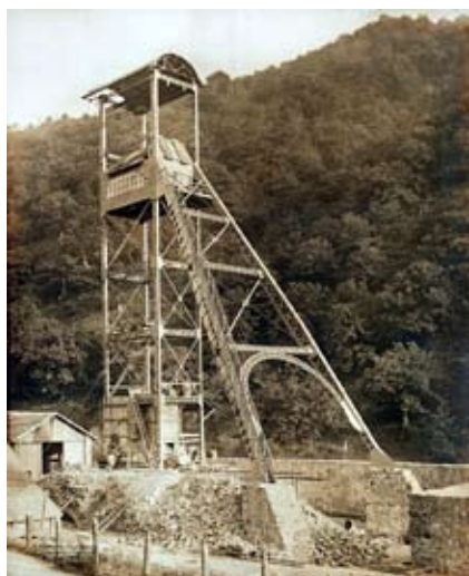
Foto 2 de Vallet de Montano. Detalle del castillete del pozo principal de Santa Bárbara.
