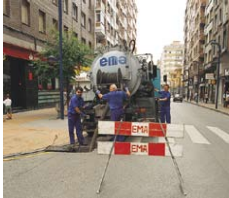
Limpieza de la red de alcantarillado
