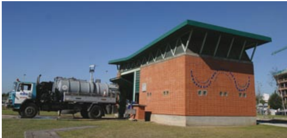
Acceso de la estación de bombeo de El Natahoyo
