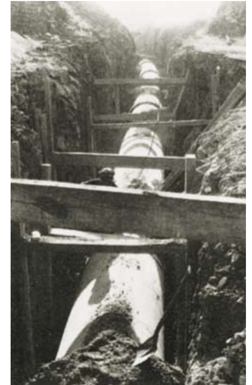
Obras de extensión de la red de abastecimiento hacia 1970
