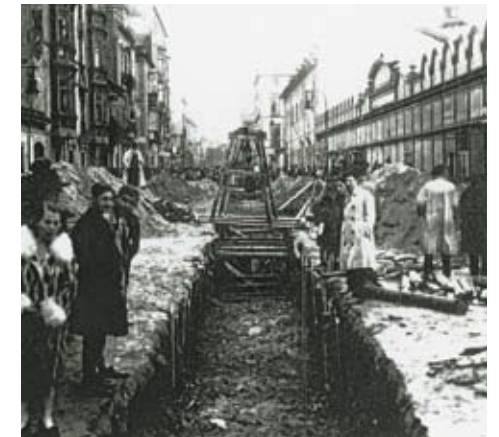
Obras de alcantarillado en la calle de Jovellanos hacia 1930
