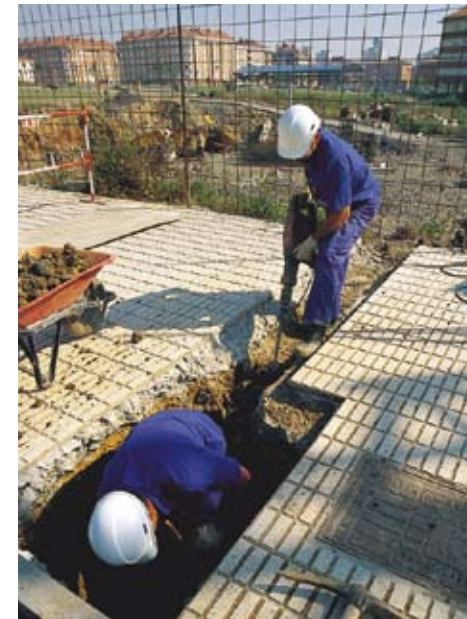
Obras de instalación de una acometida
