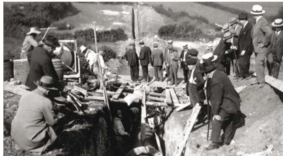
Construcción de la traída de aguas de Nava
