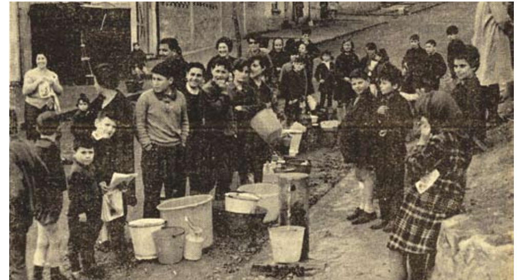
Acopio de agua debido a los cortes de suministro
