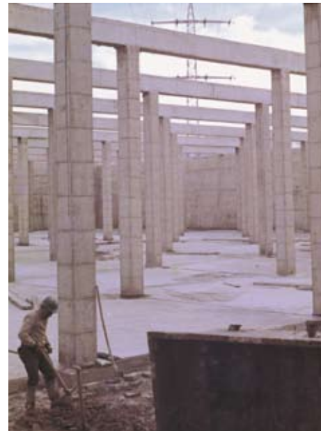
Construcción de los depósitos de La Perdiz
