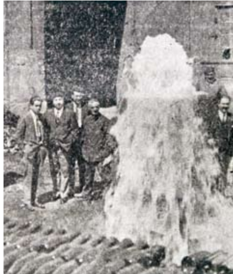
Pozo artesiano abierto en la Fábrica de Vidrios en 1926
