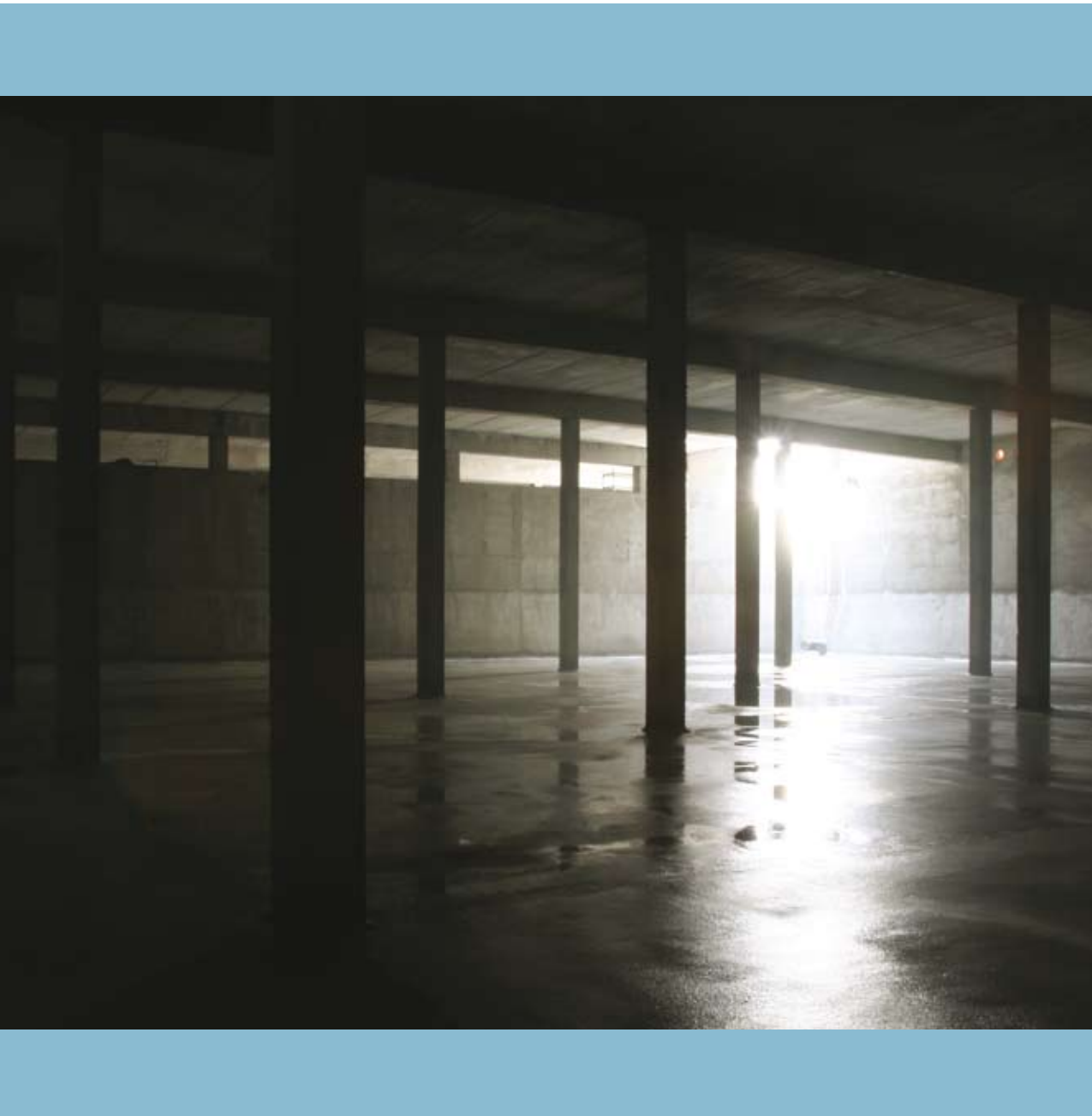
Interior del depósito de La Olla sin agua
