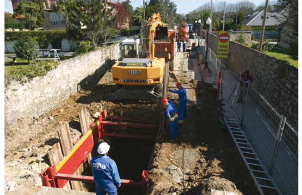
Obras de la canalización del arroyo de La Pipa
