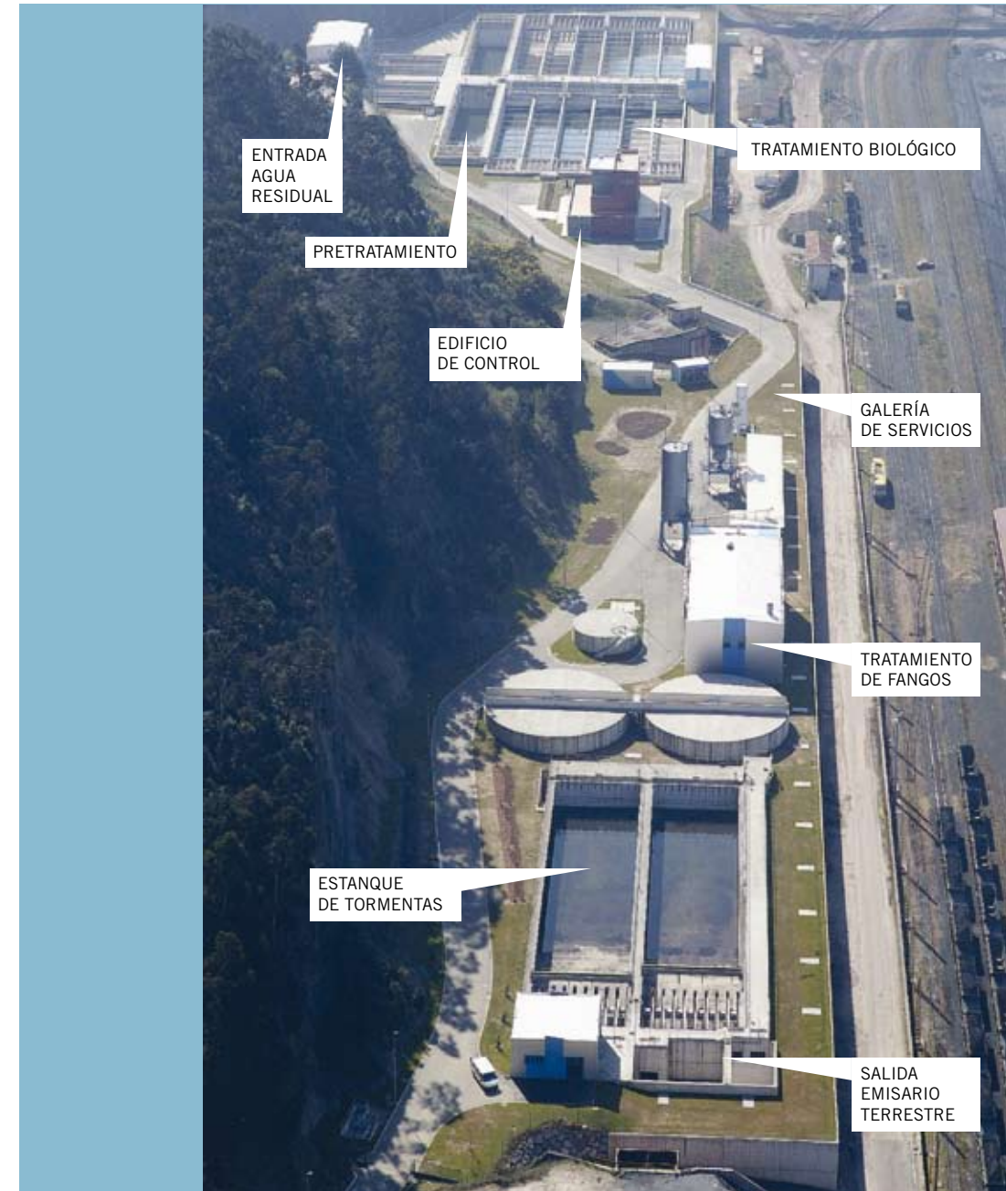
Instalaciones de la EDAR Gijón-Oeste en Aboño
