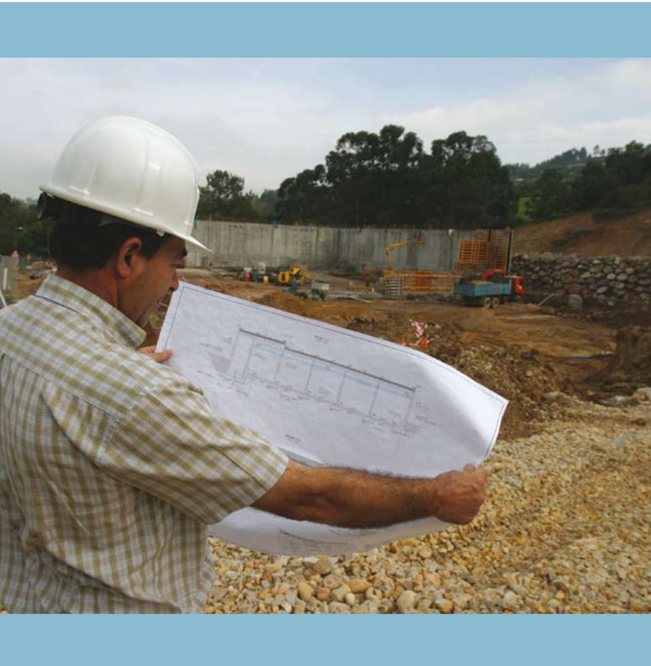
Obras de construcción del depósito de La Olla
