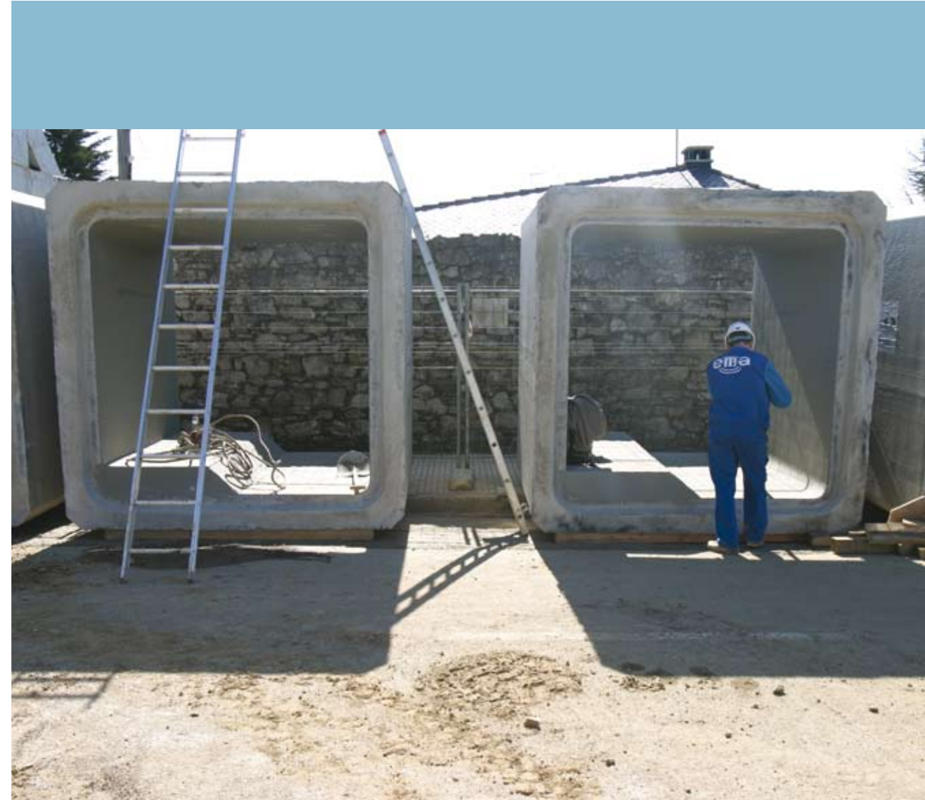
Prefabricados para la construcción de un colector
