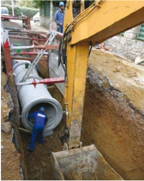
Obras de alcantarillado en Somió
