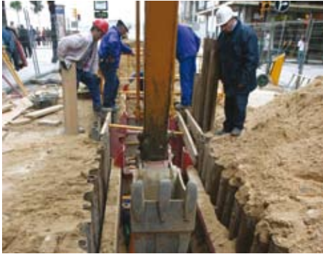
Obras de renovación de conducciones en la calle de Jovellanos
