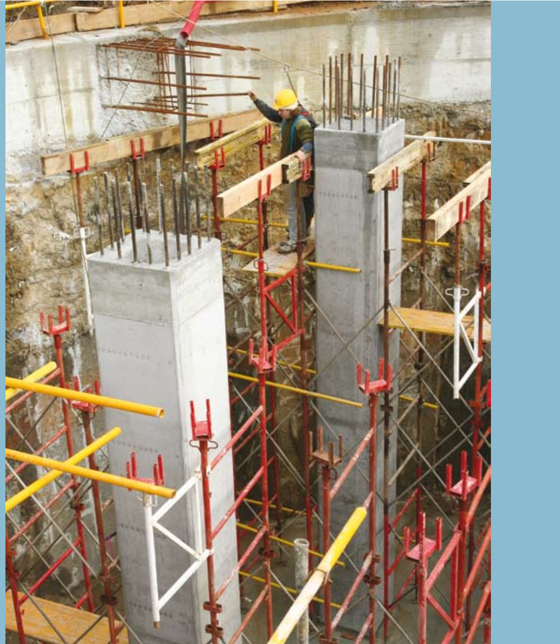
Obras de construcción del depósito de tormentas de La Guía
