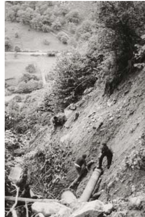
Imágenes de las obras de reparación de un argayu en la traída de Los Arrudos
