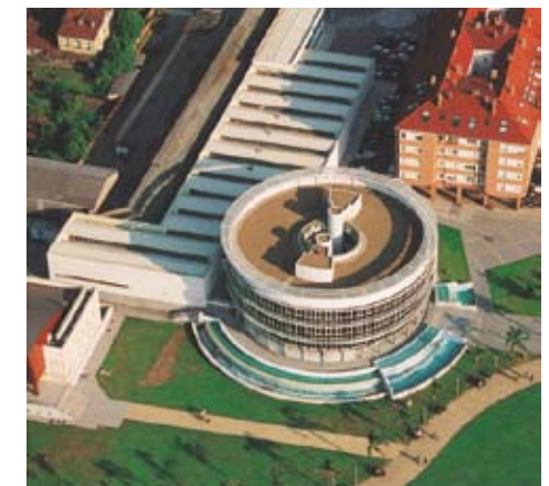
Instalaciones de la EMA en El Arbeyal
