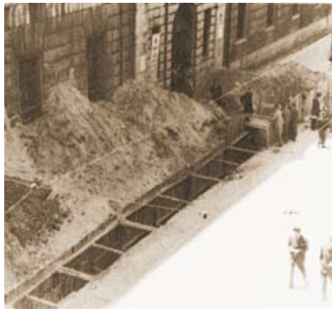
Obras de alcantarillado en la calle de Jovellanos hacia 1930
