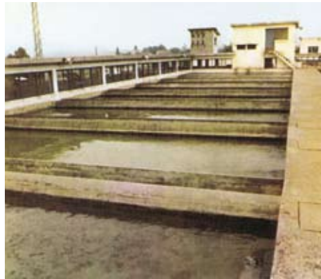
Instalaciones iniciales de la ETAP de La Perdiz
