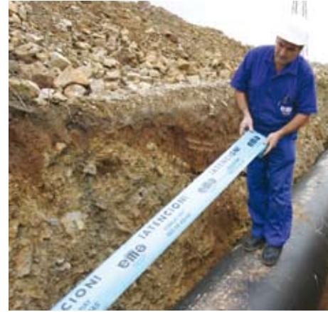
Obras de ampliación de la red de distribución
