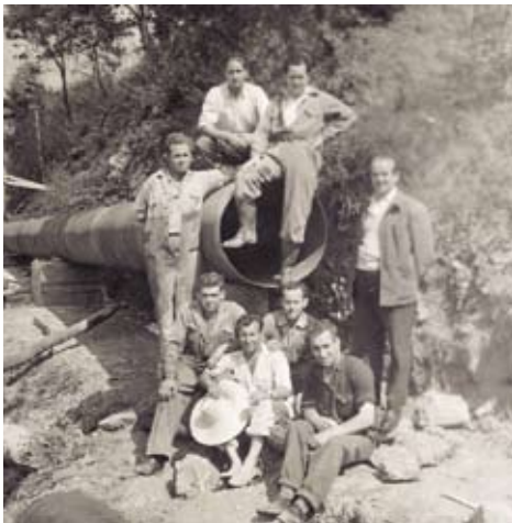
Obras de construcción de la traída de Nava
