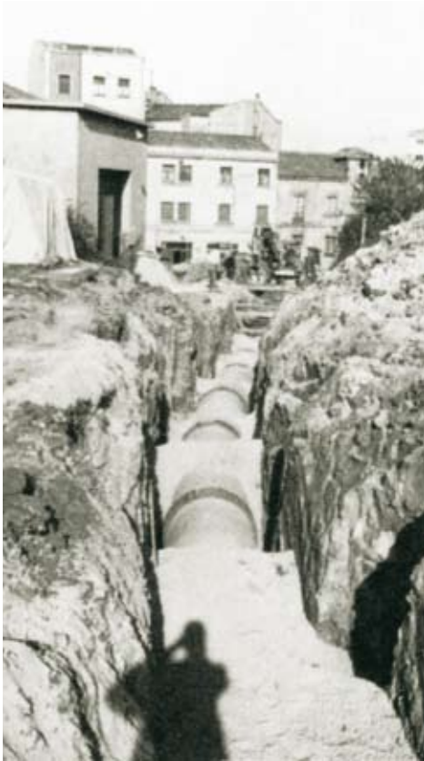
Obras de extensión de la red de abastecimiento hacia 1970
