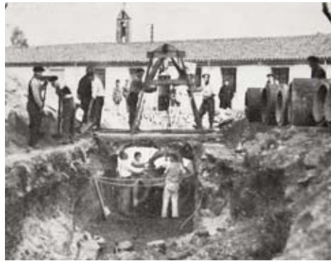
Obras de alcantarillado en Los Campos hacia 1930
