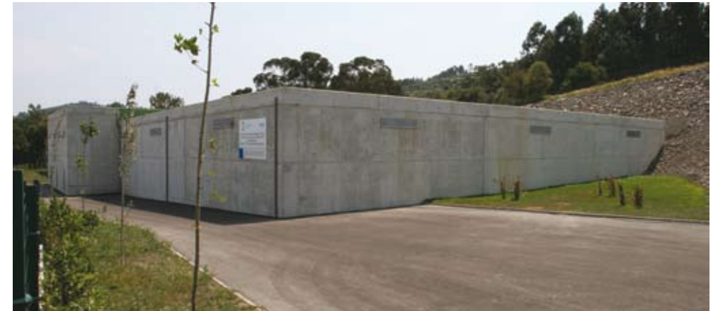
Depósito de La Olla (arriba) y ETAP de La Perdiz (abajo)
