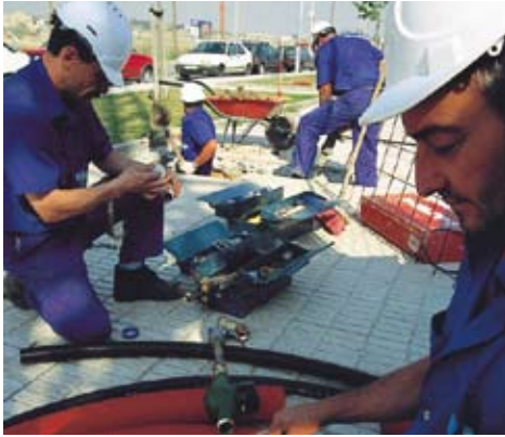
Obras de instalación de una acometida de agua
