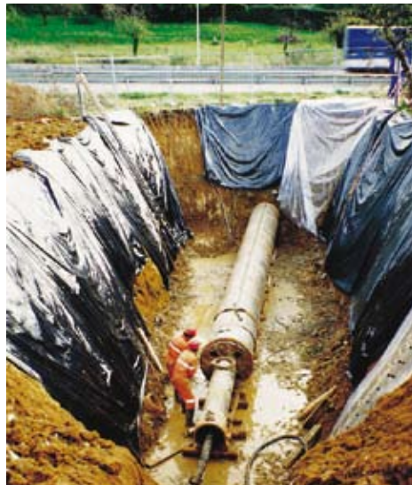
Obras en la zona rural
