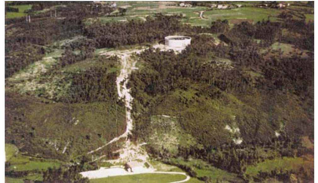
Obra de la traída de aguas del Narcea
