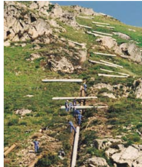
Obras en la conducción Caso-Nava-Gijón
