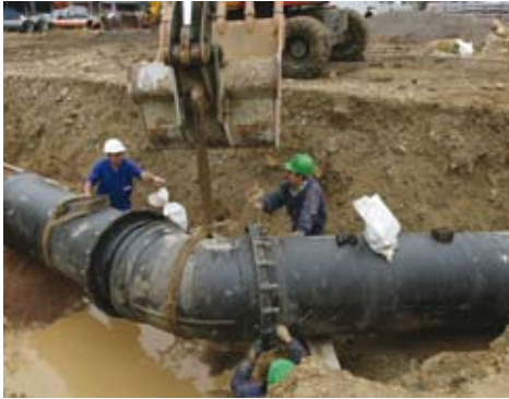
Obras de ampliación de la red de distribución
