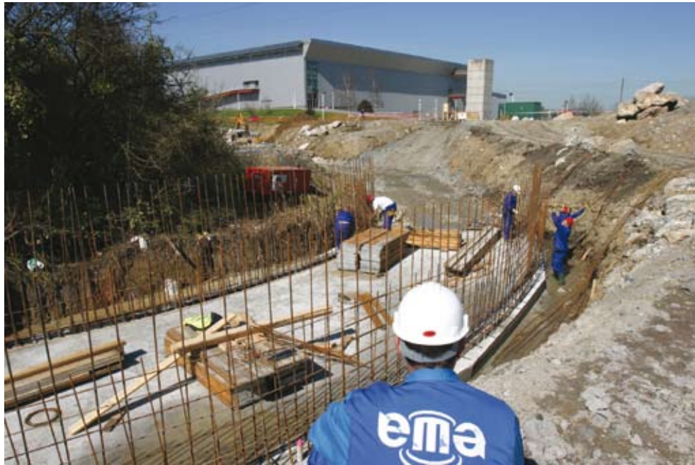
Obras de construcción del depósito de tormentas de La Guía
