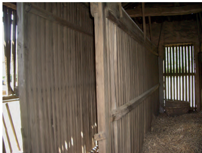
Zonas dobles de secado en un mismo costal delimitadas por mamparas de duela y dedicadas a diferentes calidades del maíz. Casa Agosto (Piñeira, Illano).
