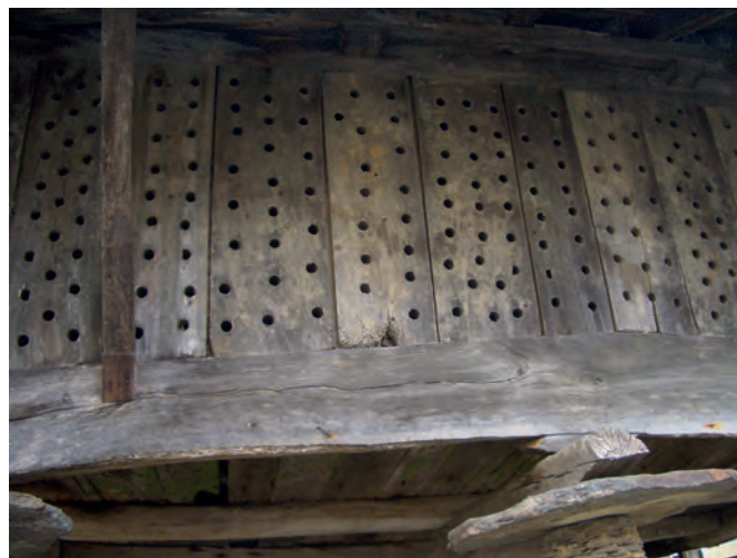
Colondras densamente taladradas para ventilación en un hórreo antiguo con engüellos y viguetas paralelas. Casa Cholitas (Setienes, Valdés).
