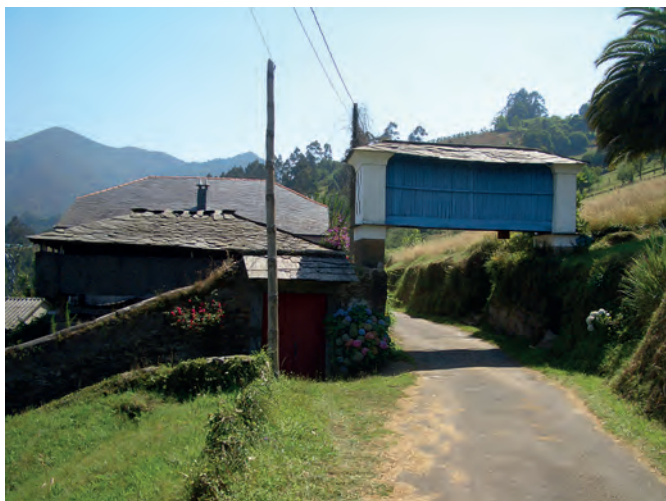
Panera y cabazo. La panera está dentro del recinto de la casería, evidenciando su mayor rango. Casa Soutín (Serandinas, Boal).
