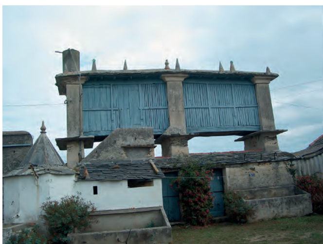
Granero mixto con tres cepas que alcanzan la cubierta. Casa Chousa (Vilaselán, Ribadeo).
