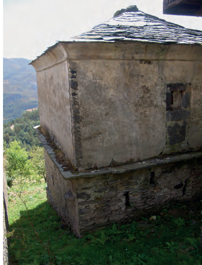
Cubierta a cuatro aguas en una granera antigua. Casa Bartola (Villanueva, Boal).
