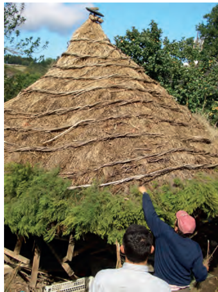
Las ramas de brezo se comienzan a colocar en el alero del techo.
