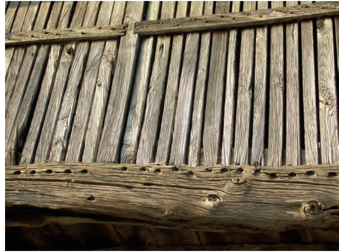
Duelas encajadas y orificios de salida del agua. Casa Sierra (Taramundi).
