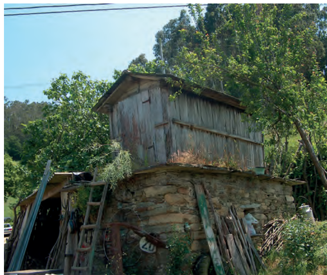
Granero de madera sobre base cerrada de piedra y con cubierta a dos aguas. Casa Perelo (Presa, Castropol).
