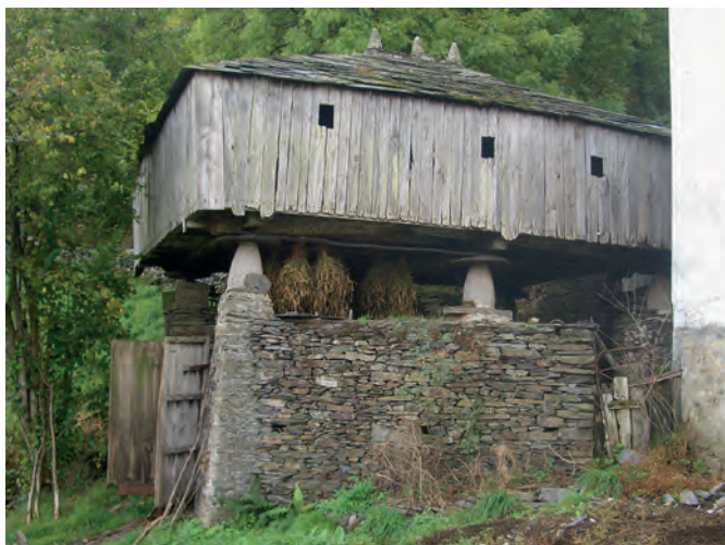
Las paneras, que aumentan la capacidad de almacenamiento, sustituyeron a los hórreos antiguos en grandes áreas de Asturias y llegaron, aunque en número muy escaso, al extremo occidental de la región. Casa de Veiga (Brañadesela, Boal).
