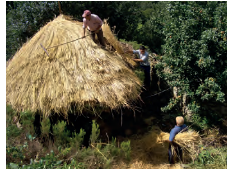
Colocando y distribuyendo correctamente la paja.
