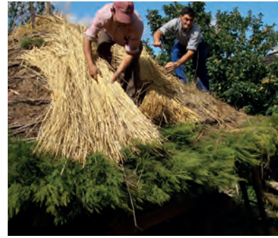
La paja se comienza a colocar suelta, comenzando por el alero.
