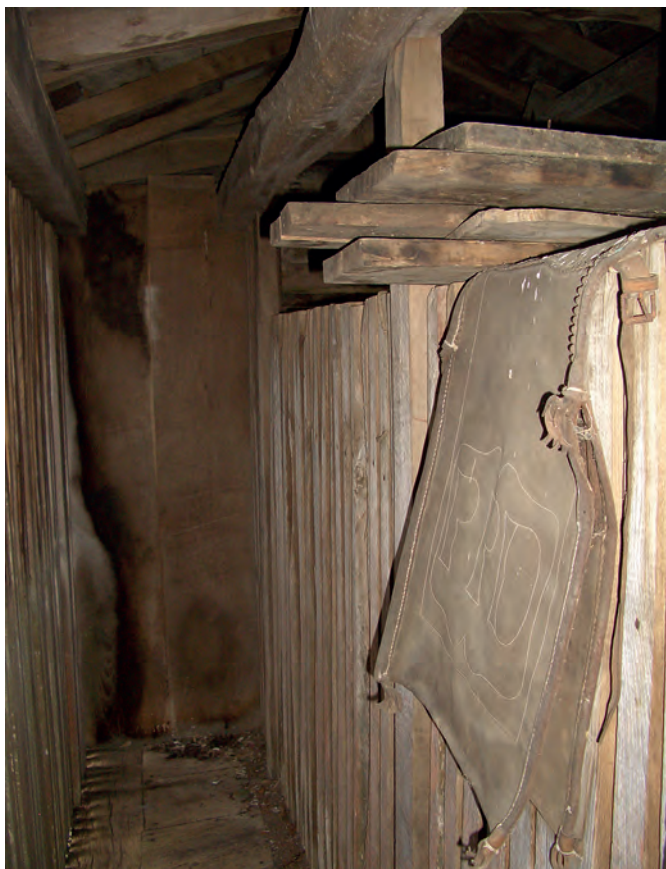
Las tuñas son estructuras poco frecuentes en los cabazos de uso mixto y cuando aparecen son más rudimentarias que las de los dedicados específicamente al almacenaje. Casa Amaro (Lugar de Baxo, Taramundi).
