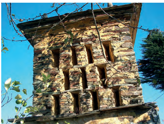
Detalle de la mampostería de las troneras en una cámara de piedra. Casa Turrado (As Aceas, Ribadeo).
