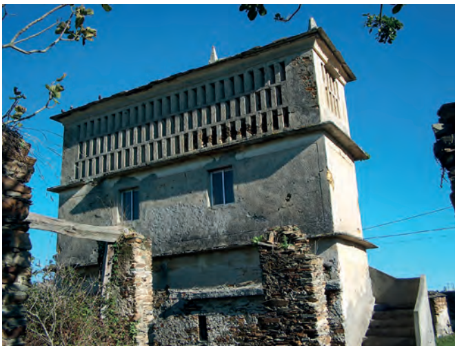
Cabazo de piedra grande. Casa Calzada (Igrexia, Ribadeo).
