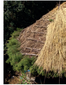
La paja se comienza a colocar suelta, comenzando por el alero.
