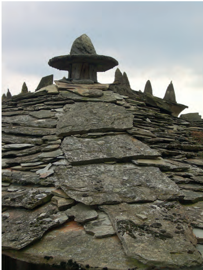
Cubierta de un hórreo especial con losas en las limas y remate característico de la zona de Taramundi. Casa Ramonzón (Piñeiro de Abajo, Taramundi).
