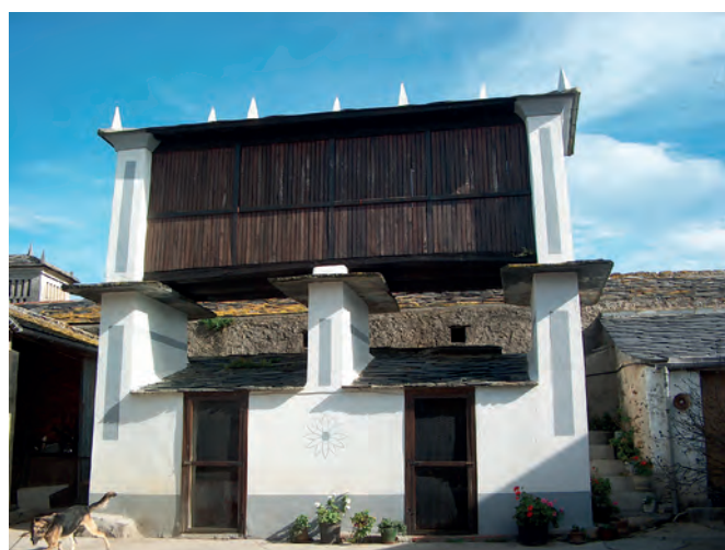
Cabazo con tres cepas y celeiros inferiores. La cepa central sólo actúa como apoyo de las vigas. Casa Xan da Pena (Río, Ribadeo).
