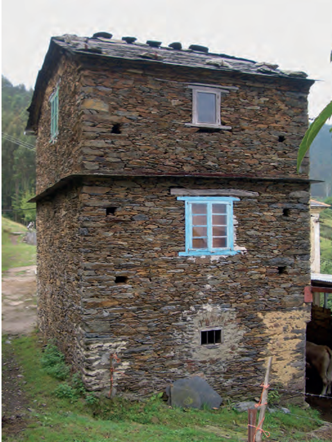
Granera de tres pisos con pequeñas ventanas en el centro de los habitáculos. Casa El Monte (Vivedro, Coaña).
