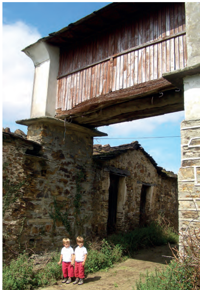
Cabazo en el centro de un núcleo de población y bajo el cual discurre un camino. Casa Julián (Montouto, Vegadeo).
