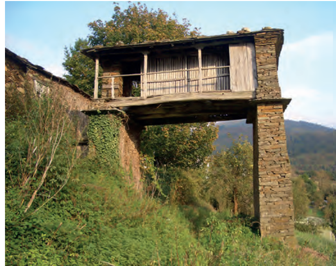
Granero de uso mixto con doble corredor. Puede observarse como las cepas son diferentes a nivel de la cámara. En este caso, el acceso a la cámara se realiza mediante una puerta central. Al fondo del costal se aprecia un pequeño compartimento de almacenamiento. Casa do Juez (Taramundi).
