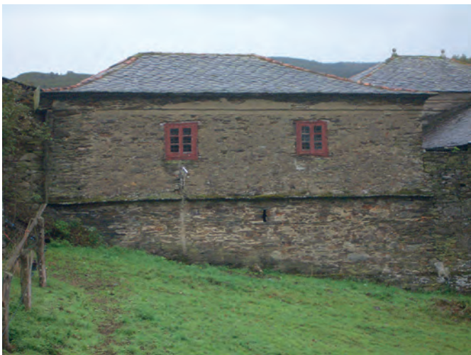
Cuando las graneras están adosadas a otras edificaciones, una solución para aislar la cámara es hacer que el tornarratos remonte en vertical hasta la cubierta, como en este ejemplo de Santa Eulalia de Oscos (Casa d'a Pruída).
