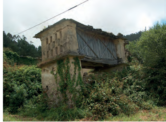
Costales de duela arriostrados por tirantes en cruz, en un cabazo antiguo. Casa Lodos (Grandallana, Castropol).
