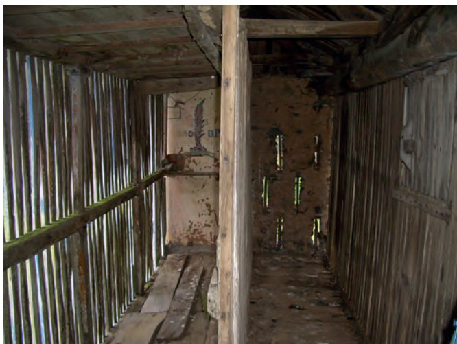
Aspecto de una cámara con dos zonas de secado. Nótese que la estructura del penal también sigue esta partición de la cámara. La parte izquierda no se utilizaba para el maíz y tiene un pequeño desván. Decoración interior con una planta de maíz. Año 1890. Casa Amago (Barganaz, El Franco).
