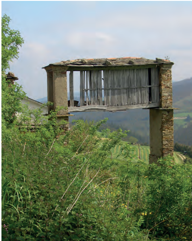
Cabazo perpendicular a la ladera y elevado para captar los vientos locales dominantes del sur. Casa Ferreiro (Coba, Vegadeo).
