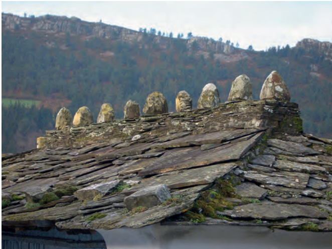
Paredilla coronada con cantos rodados o penedos como remate de una cubierta de un granero de uso mixto. Casa Agustín (A Rondía, Boal).
