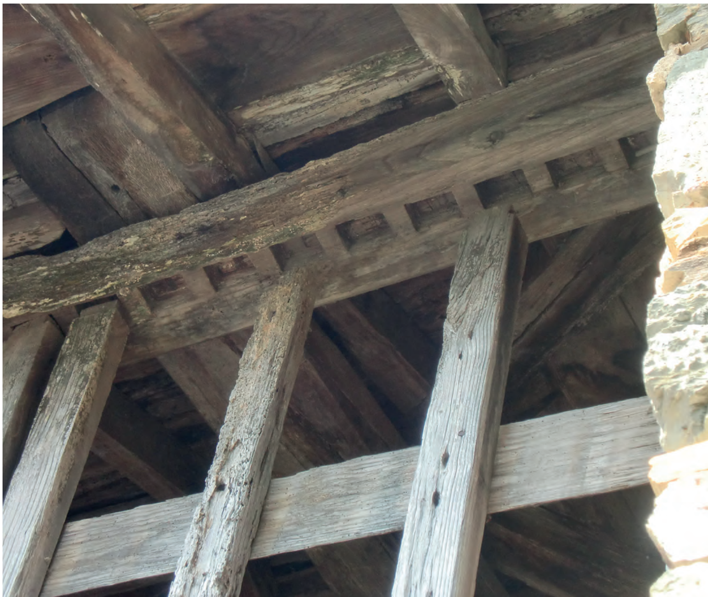
Encajes de las duelas en la viga superior de un cabazo modelo antiguo. Casa Livita (Castro, Taramundi).
