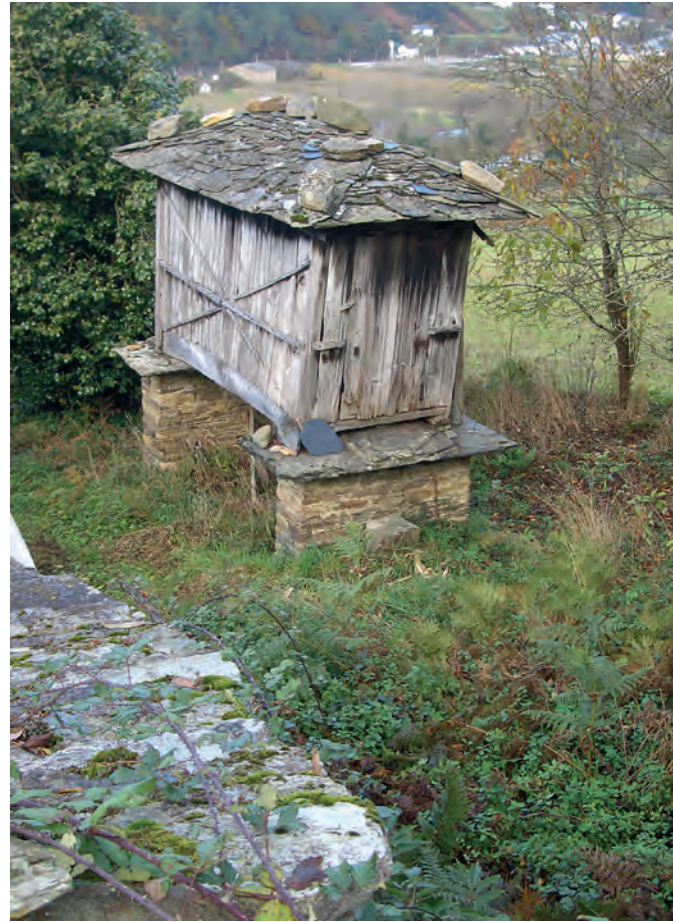
Cabazo de madera con arriostramientos en los costales. Casa da Granda (O Castro, San Tirso de Abres).
