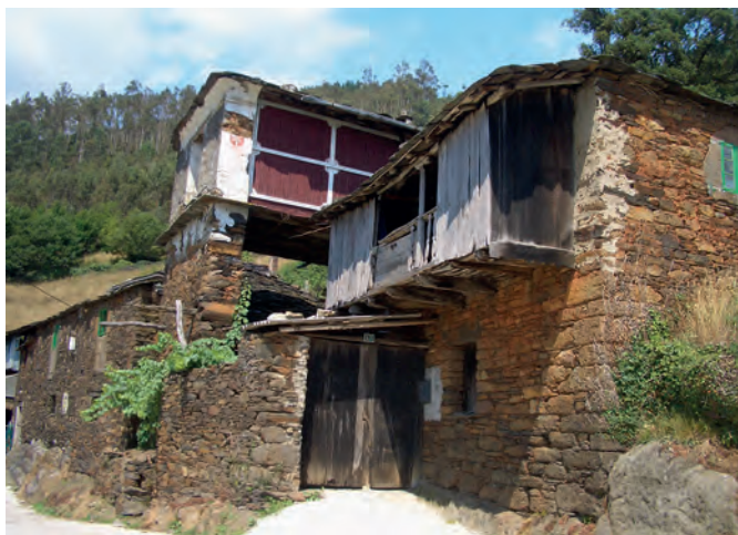
Granero de uso mixto ubicado muy próximo a la vivienda. Casa Arroyo (Zedemonio, Illano).
