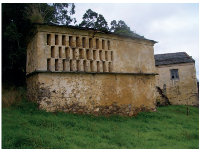
Granero de piedra y uso mixto de grandes dimensiones. Casa do Liñeiro (A Devesa, Ribadeo).
