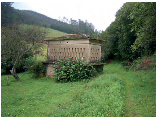
Granero de piedra con la cámara sustentada sobre una pequeña base. Casa Felipe (Porzún, Vegadeo).
