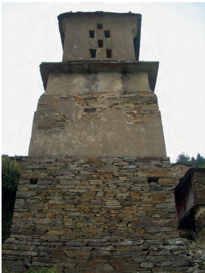
Ejemplo de cepas elevadas de sección decreciente en un cabazo de tipo antiguo. Casa Ramonzón (Piñeiro de Abajo, Taramundi).
