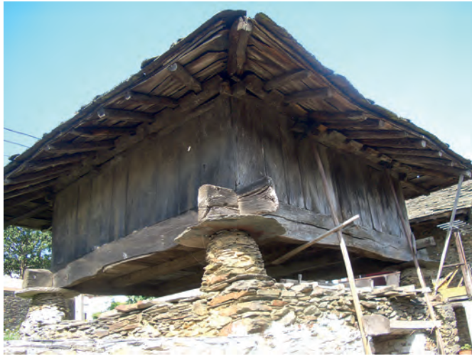
La cámara del hórreo de tipo asturiano está construida enteramente en madera. Hórreo con aleros sobresalientes en Trelles, Coaña (Casa Capachina).
