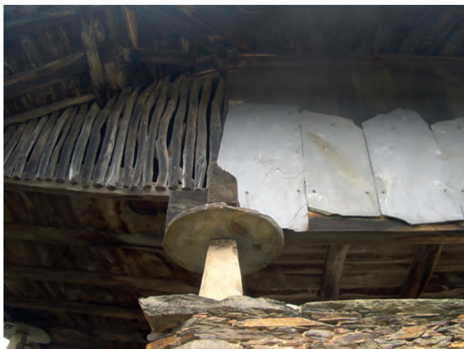
Cabazo externo cubierto por un faldón que alarga la cubierta y apoyado sobre pies independientes a los de la panera. Casa del Mazo (Armental, Navia).
