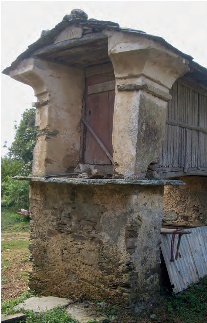
Cepas de sección decreciente, aleros amplios y cubiertas laxas o de bajo ángulo son algunas de las características de los cabazos antiguos que les confieren sin duda un gran porte y belleza. Casa A Pruida (Almedía, Vegadeo).
