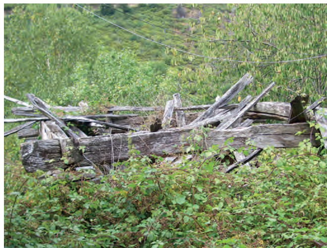
La mayor parte de los antiguos hórreos con cubierta de paja del occidente asturiano sólo son reconocibles por sus restos. De los ejemplares que se han censado en esta zona, la mayoría se encuentran en este estado. Casa A Veiga (Penafurada, Grandas).
