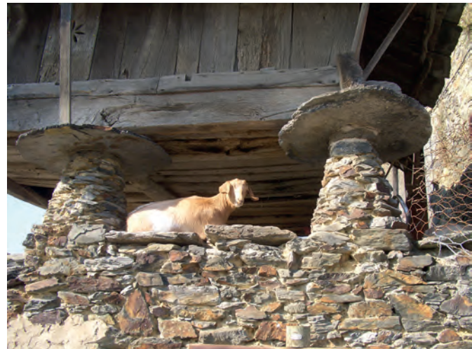
Pies de mampostería gruesa en un hórreo antiguo. Casa Sobristante (El Chano, Valdés).
