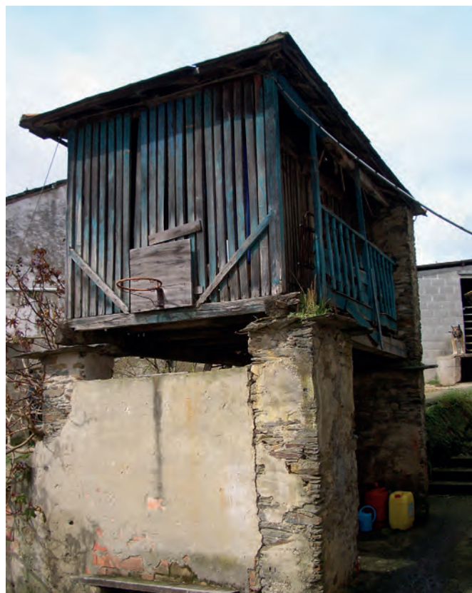
Granero de uso mixto con corredor construido en madera. Casa Baragaña (Villapedre, Navia).
