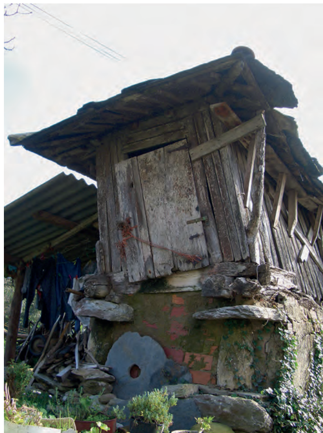
El uso de pies de piedra para la sustentación de los cabazos es muy poco frecuente en los tipos asturianos y restringido a una zona muy concreta del concejo de Castropol. Cabazo de madera a cuatro aguas sobre pies de piedra y muelas de pizarra. Casa Redondo (Vilavedelle, Castropol).
