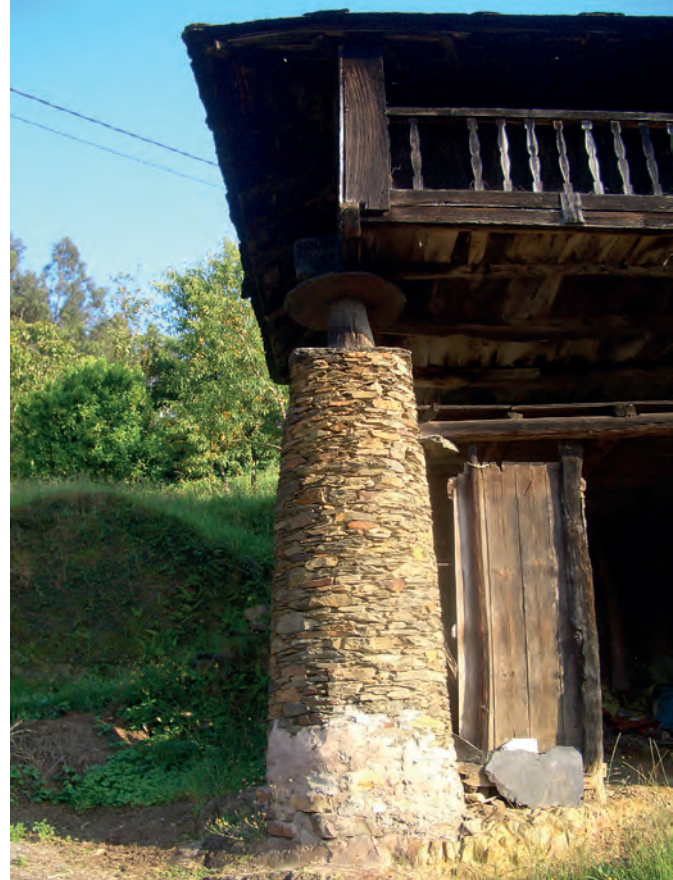
Pie de mampostería de gran altura, rematado con otro de madera en una panera antigua con corredor al valle. Casa Berbegueira (Sabariz, Coaña).
