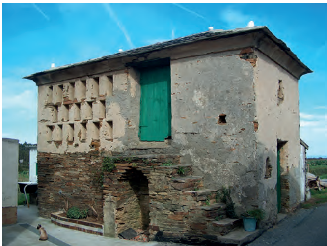
Granero de uso mixto construido en piedra, con acceso costal y sin imposta perimetral. Casa Corneta (O Tombín, Ribadeo).
