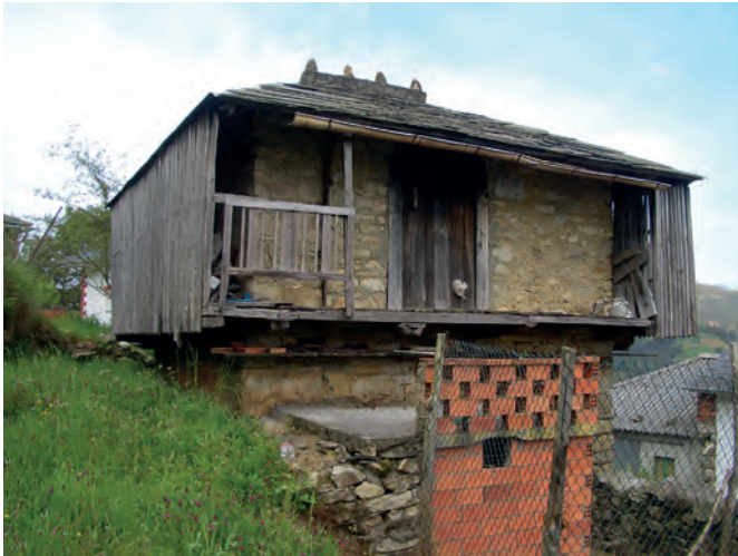
Granero de almacenaje de piedra y construido sobre cepas. Casa Lorenzo (Illaso, Villayón).
