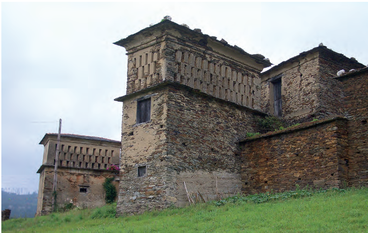
Graneros de piedra y tres pisos. Casa Rabón y Casa da Caseira (Abres, Vegadeo).
