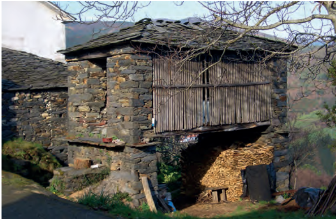
Cabazo de uso mixto con remate de la cubierta mediante pizarras trabadas. Casa da Cruz (Silvón, Boal).
