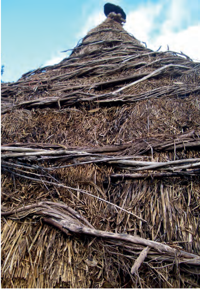
Las cubiertas de paja techadas a beo eran muy frecuentes en lo hórreos del occidente asturiano y concejos gallegos limítrofes. Casa Muiña (Xestoso, Grandas).
