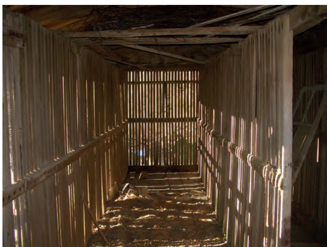
Interior de la cámara de un granero de uso mixto. Casa Carballal (Carballal, Boal).
