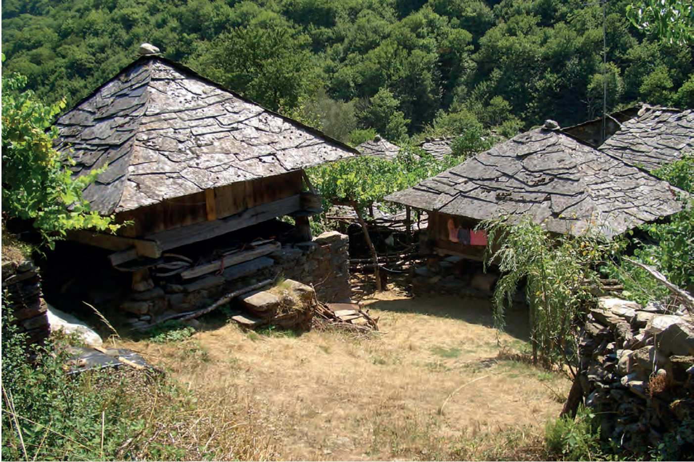
Formas equidimensionales caracterizan a los graneros de almacenaje, con cámaras amplias y de poca altura. Hórreos de montaña en Soutelo (San Martín de Oscos).
