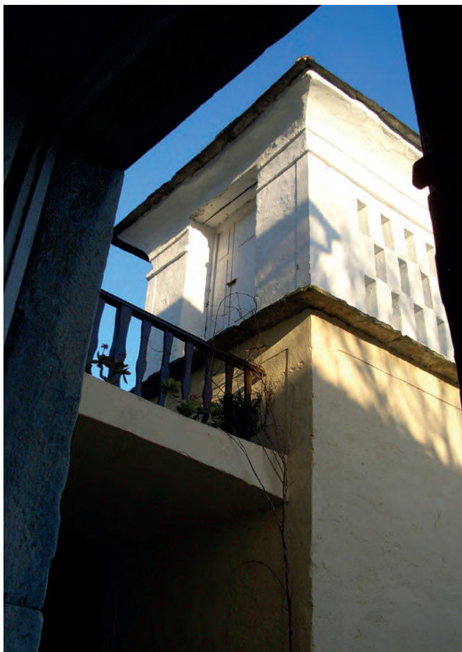
La posición del granero con relación a la vivienda y, más en concreto, la relación entre los accesos a ambas construcciones, es un factor muy importante que casi nunca es dejado al azar. Granero de piedra en Casa Peleýón (Figueras, Castropol).
