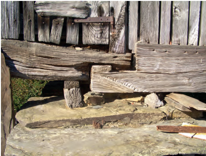
Encaje de dos vigas sobre una cepa central y detalle de los orificios de salida del agua, en este caso de poco calibre. Casa da Rata (Vaodinsua, San Tirso de Abres).
