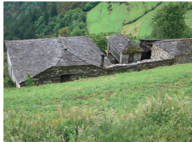
En las zonas de montaña, la pendiente del terreno y la falta de espacio exigen, con frecuencia, una ordenación muy cuidada de las construcciones en el conjunto de la casería. Granero de uso mixto, Casa Enrique (Bustello, Illano).
