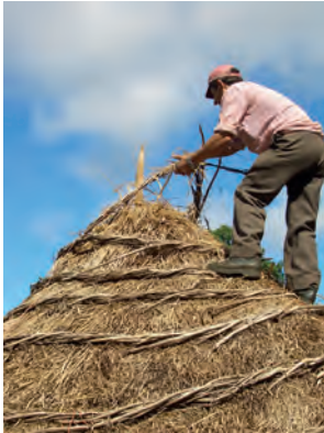
Desmontando el remate del techo.
