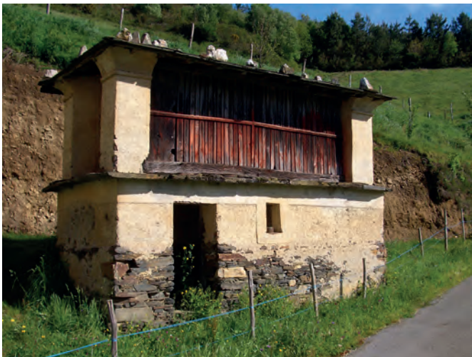
Cabazo desplazado con respecto a la vivienda. Casa del Rey (Obanza, Castropol).
