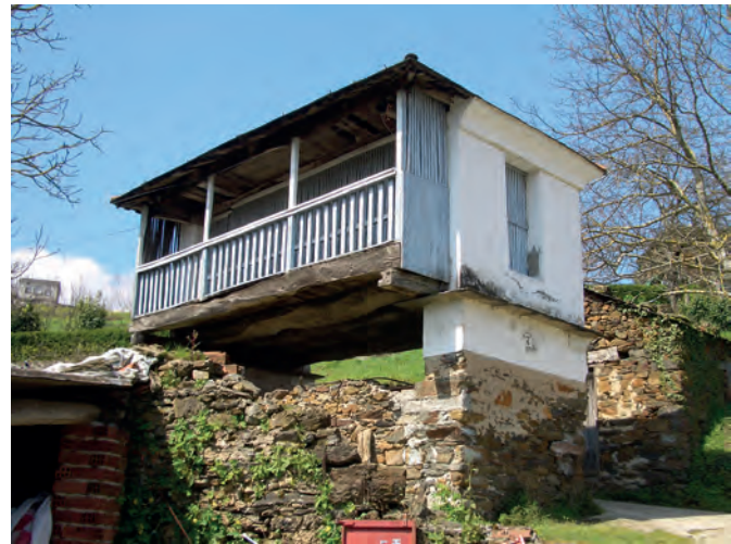
Cabazo con corredor exterior orientado al valle, en el que toda la estructura vuela fuera de las cepas. Casa Concha (La Escrita, Boal).
