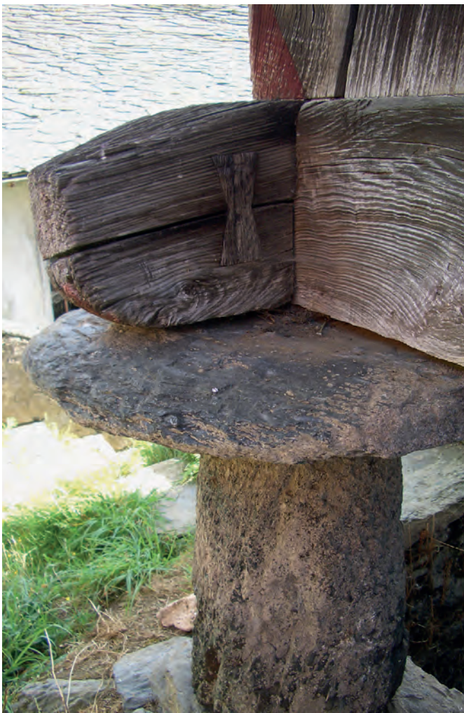
Trabes encajadas al ras. Casa Villasevil (Villanueva, Boal).
