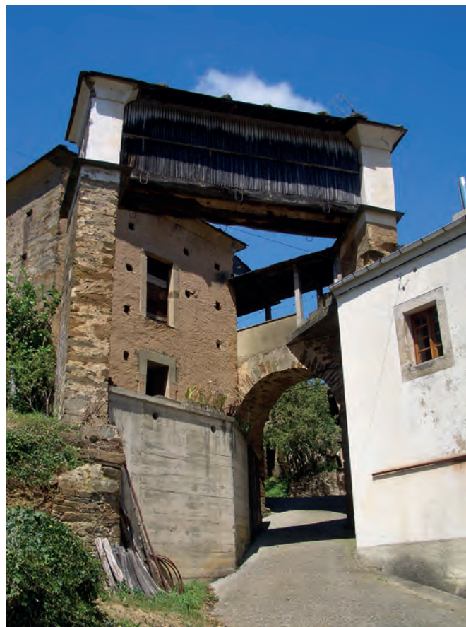
El cabazo, elevado con frecuencia sobre el terreno, busca las corrientes de aire para asegurar la aireación del grano. Casa Ron (Merou, Boal). Este mismo cabazo fue un motivo para los excelentes dibujos de Efrén García (publicados en Hórreos, paneras y cabazos asturianos , 1979). La foto ha sido hecha desde el mismo ángulo que el dibujo de este autor, 35 años después.
