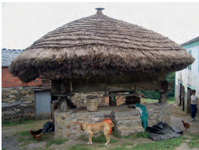
El concejo de Grandas es uno de los más ricos en cubiertas de paja. Hórreo de techo con aleros de brezo y varias capas de paja bien conservado en Casa A Lieira (A Lieira, Grandas).
