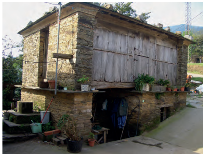
Cabazo con costal continuo de tablón que encierra una zona de almacenaje. Casa Sela (Castromourán, Vegadeo).
