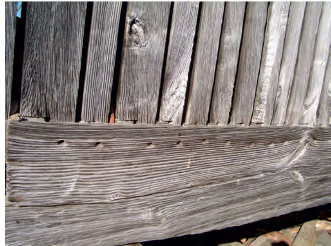
Encaje de dos vigas sobre una cepa central y detalle de los orificios de salida del agua, en este caso de poco calibre. Casa da Rata (Vaodinsua, San Tirso de Abres).
