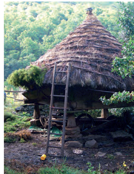
Las ramas de brezo se comienzan a colocar en el alero del techo.
