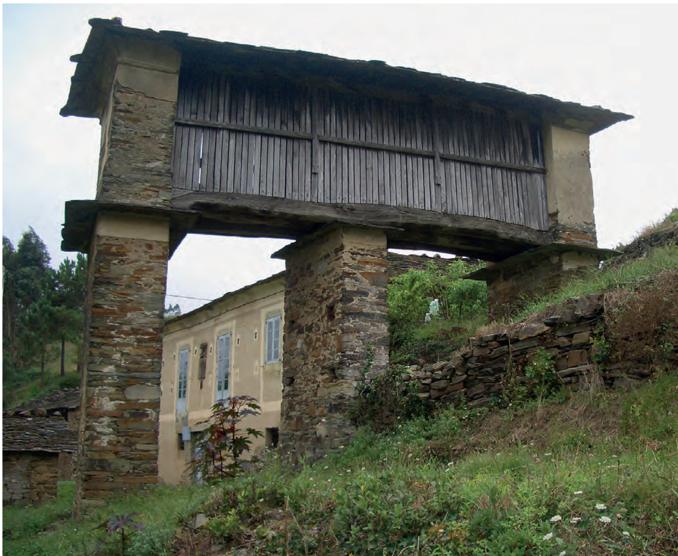
Granero de secado construido en piedra y madera, característico de la maraña lucense y occidente asturiano. Casa Boca de Canle (Ría de Abres, Trabada).
