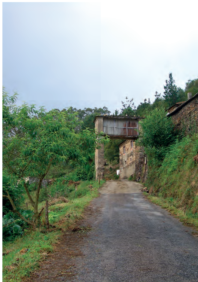
Cabazo mixto orientado perpendicular a la ladera y elevado para mejorar su funcionamiento. Hay que resaltar que, cuando fue construido este granero, las exigencias de altura para circular por debajo eran bastante reducidas. Casa Fonte da Pena (Candaosa, Castropol).
