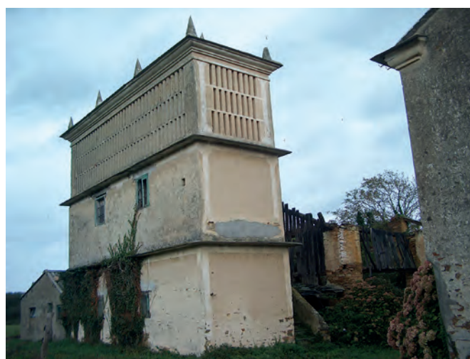
Granero de piedra con doble imposta para proteger la cámara de secado y la panera. Casa Villalba (Vilandriz, Ribadeo).
