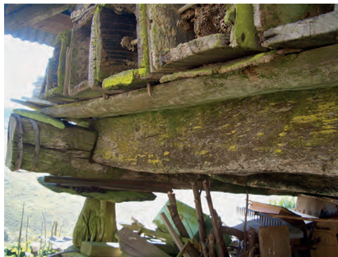
Trabes encajadas a media madera en un hórreo de techo modificado. Casa de Baxo (Bustarville, Negueira de Muñiz).
