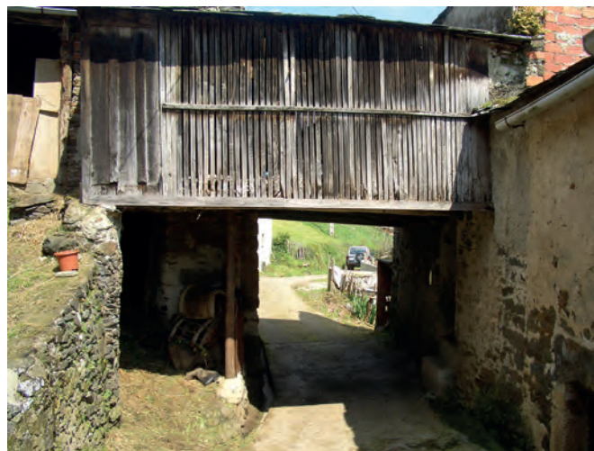
Cabazo construido entre dos casas con acceso interior. Casa Pericón (Muñón, Boal).
