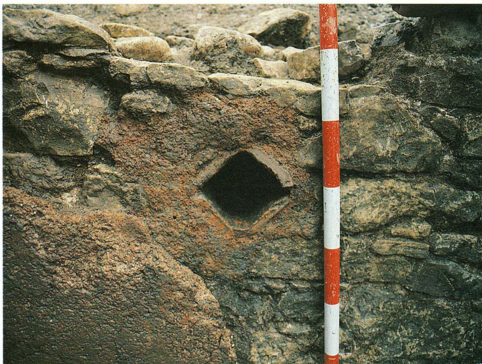
Lám. XIII.—Detalle del aliviadero del aljibe.
