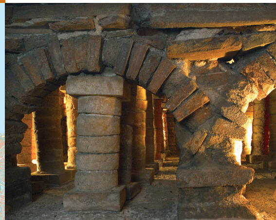
Hipocausto de arquillos de la sala de sudoración, de planta circular
