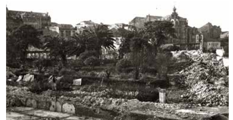
Constantino Suárez Solar resultante de la demolición del Hospital de Caridad. Enero 1937 Muséu del Pueblu d'Asturies
