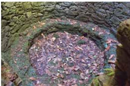
**Fotografía 7.** En los hornos de cal de marcha intermitente, histórica y tecnológicamente anteriores a los de marcha continua, la piedra caliza a calcinar forma una bóveda que se apoya en un ancho reborde interior en el fondo del calero. En la foto, el calero de Castandiel, en Navelgas (Tineo).
