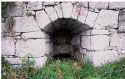
**Fotografías 17 y 18.** El calero de Udrión de Arriba (Trubia), presumiblemente de marcha continua. Construido en caliza blanca, presenta dos bocas en arco al exterior, y un dintel al fondo de cada una, en la puerta del hogar. Las bocas en arco eran típicas de los caleros intermitentes tradicionales; en éste, constituyen un rasgo singular.
