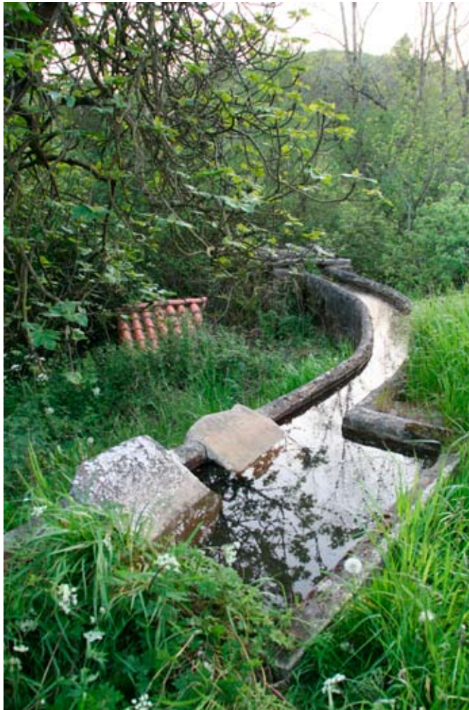
Piedras lavaderas colocadas en el canal del molino de Vega. Illas.
