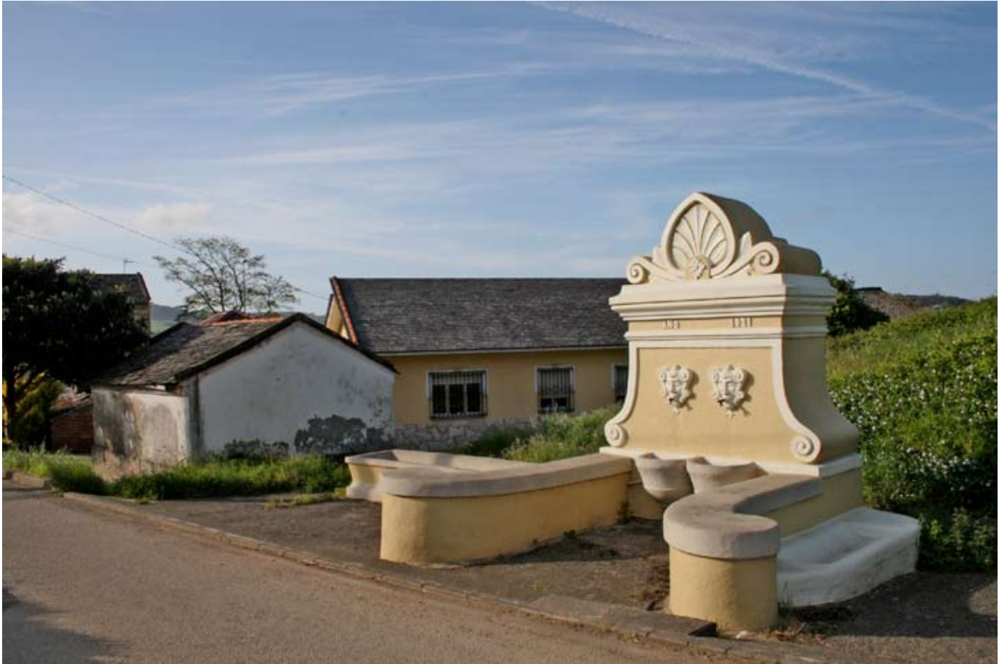
Fuente y abrevadero de Vilavedeye construido en 1921. Castropol.
