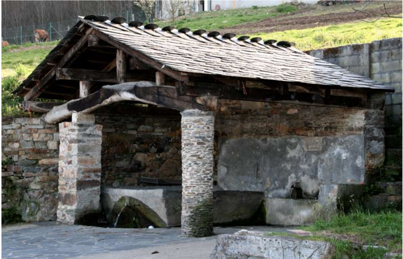
Lavadero de Penafonte fechado en 1932. Grandas de Salime.
