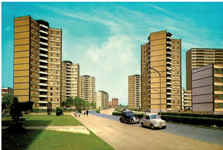
La Ronda de Camiones y las 1500 viviendas de Pumarín. Muséu del Pueblu d'Asturies (Gijón/Xixón).
