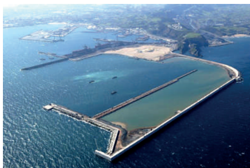
Vista aérea de las obras de ampliación del puerto de El Musel, h. 2010. Archivo SATO.
