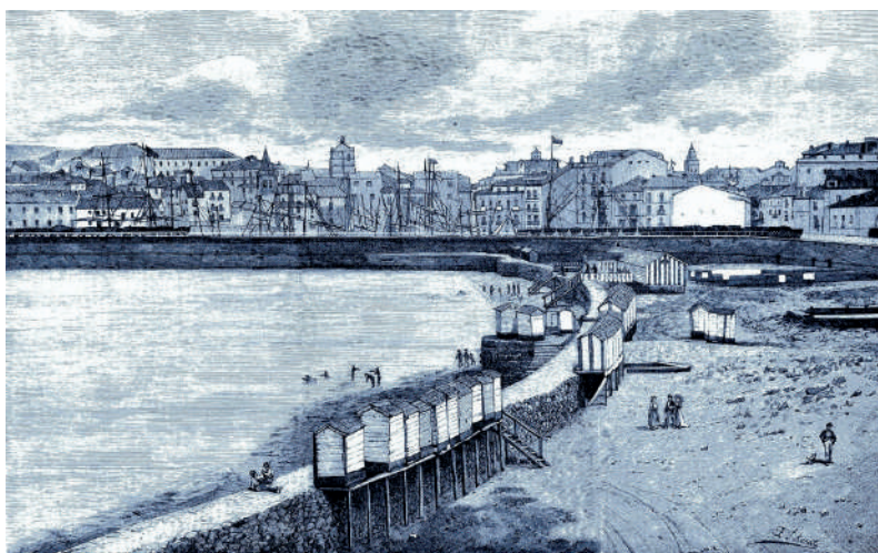
Mariano Ovejero (grabador). Vista de los muelles de Fomento en construcción sobre la playa de Pando. La Ilustración gallega y asturiana (1879).
