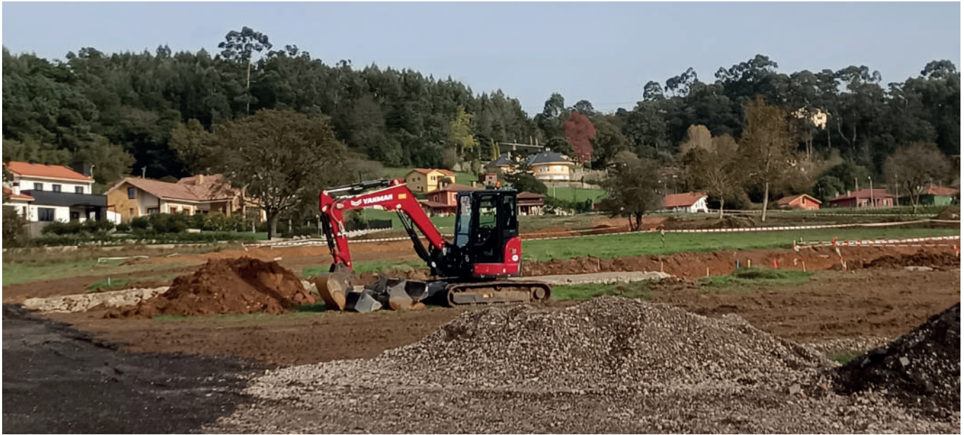
Urbanización de parcelas para la construcción de viviendas unifamiliares en el entorno del Camín de la Frontera, en Cabueñes. Foto: J. Granda.
