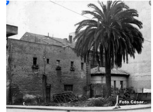
Patio del antiguo Ateneo Obrero de La Calzada antes de su derribo (Foto de la página de Facebook de Foto César, Gijón/Xixón.)
